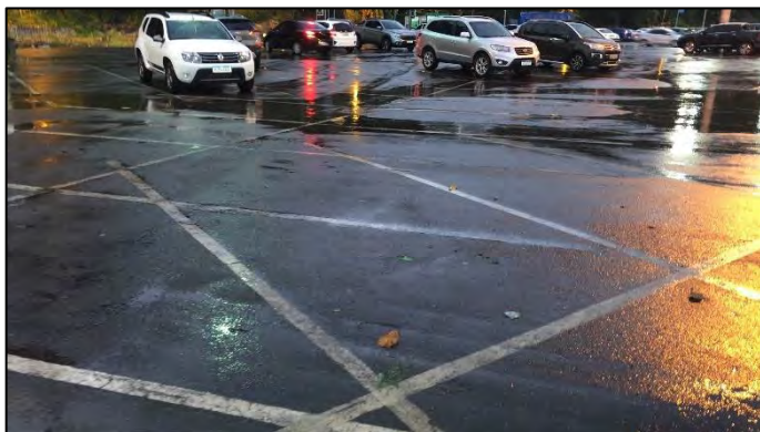
Figura 113: INCONFORMIDADE - falha na demarcação de vagas Estacionamento EE
