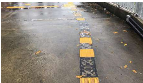
Figura 121: INCONFORMIDADE Piso Tátil descolando na rampa de acesso Leste
