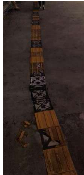
Figura 114: INCONFORMIDADE Piso Tátil descolando na rampa de acesso Leste
