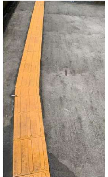
Figura 114: INCONFORMIDADE Piso Tátil descolando na rampa de acesso Leste
