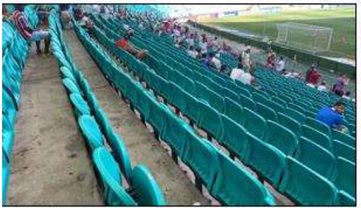
Figura 97: N5 bloco 117 eixo 40
