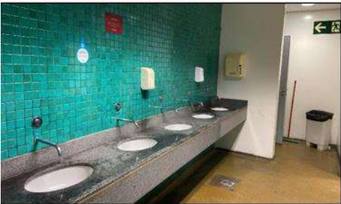
Figura 103: Sanitário N5 eixo 51
