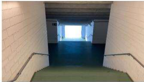
Figura 37: Túnel de acesso
