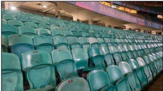
Figura 77: N5 Eixo 56 Bloco 124
