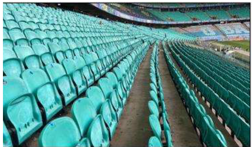
Figura 61: N5 bloco 127 eixo 60
