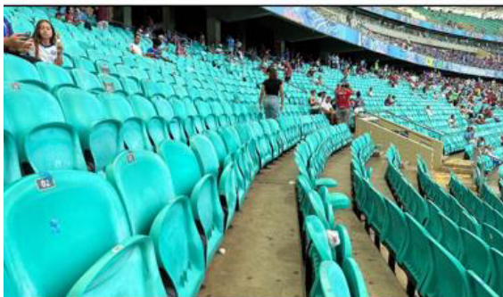
Figura 192: N5 eixo 65 Bloco 129
