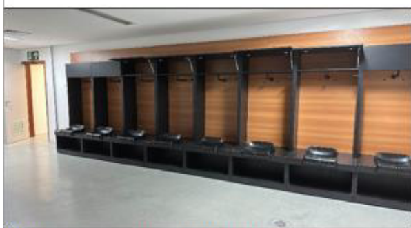
Figura 75: Apoio Vestiário Bahia
