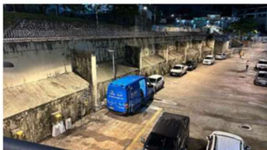
Figura 318: Rampa de acesso Oeste
