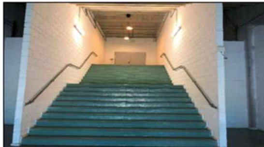
Figura 131: Tunel de acesso ao campo
