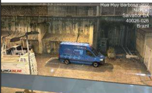
Figura 418: Rampa de acesso oeste
