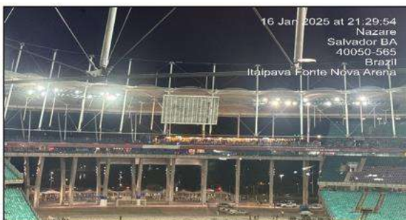
Figura 283: Inconformidade Telão Sul
