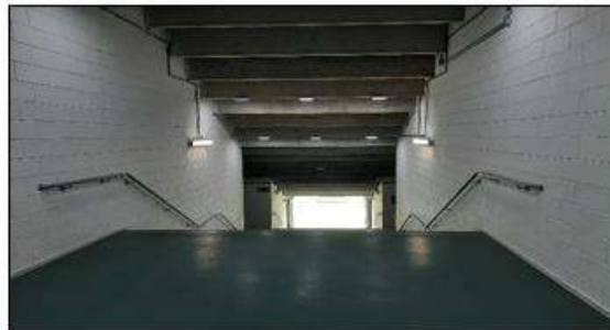
Figura 148: Tunel de acesso ao campo
