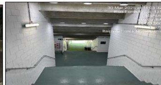
Figura 205: Tunel de acesso ao campo
