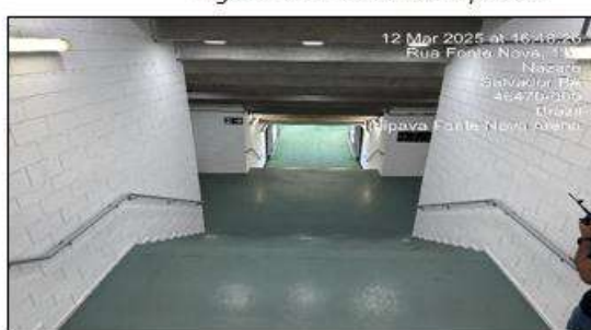
Figura 177: Tunel de acesso ao campo
