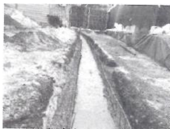
Foto 02 – 03/08/2023 Execução de canaleta em concreto armado (20 cm x 20 cm)
