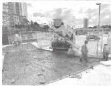
Foto 06 – 16/09/2023 Execução de piso em concreto armado
