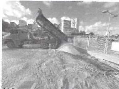
Foto 03 – 13/09/2023 Fornecimento de areia para dreno
