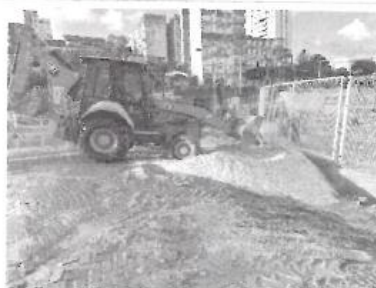
Foto 04 – 13/09/2023 Enchimento de areia para dreno
