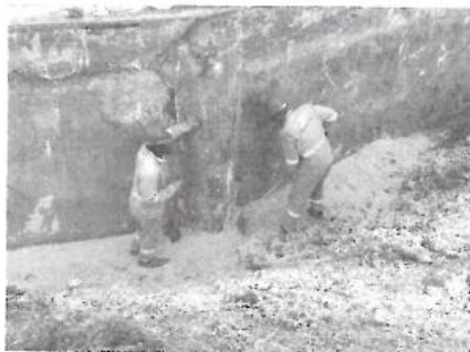
Foto 01 – 12/09/2023 Regularização manual e compactação do solo
