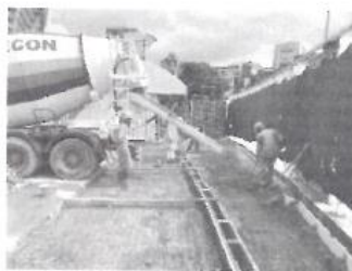
Foto 03 – 03/08/2023 Concretagem de canaleta em concreto armado
