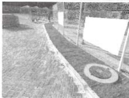
Foto 08 – 20/09/2023 Recomposição do piso intertravado
