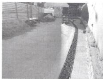
Foto 05 – 08/08/2023 Reinstalação dos drenos
