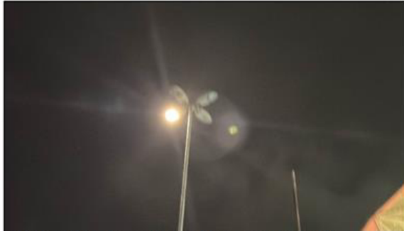
Figura 176: Inconformidade - Poste com luz apagada Estacionamento EE
