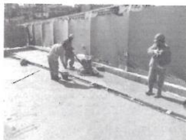
Foto 04 – 03/08/2023 Concretagem de canaleta em concreto armado (20 cm x 20 cm)
