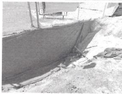
Foto 02 – 13/09/2023 Instalação de manta Geotêxtil Bidim
