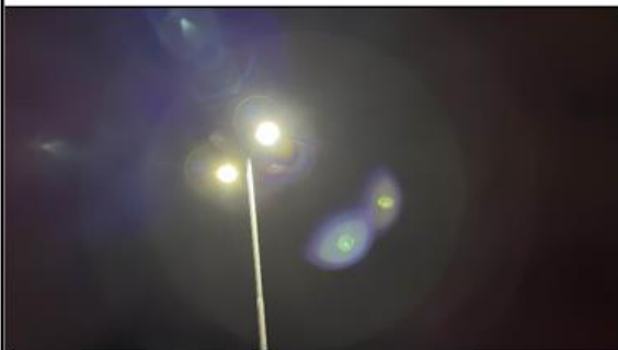
Figura 171: Inconformidade - Poste com luz apagada - Estacionamento EE
