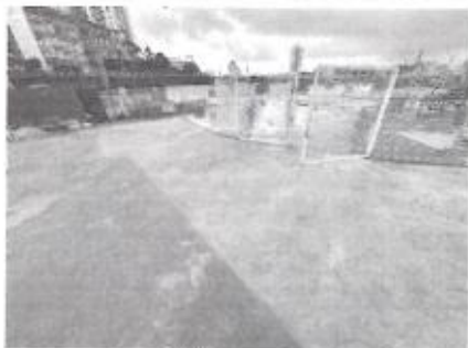
Foto 07 – 20/09/2023 Recomposição do piso em concreto armado
