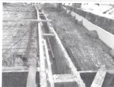
Foto 01 – 03/08/2023 Execução de canaleta em concreto armado
