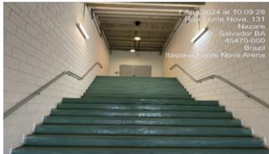
Figura 85: Túnel de acesso
