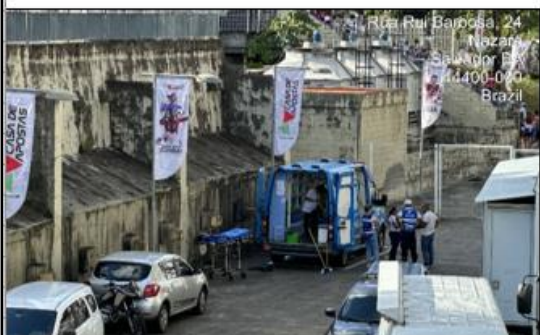
Figura 222: Rampa de acesso Leste
