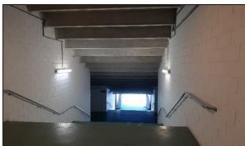
Figura 70: Tunel de acesso ao campo
