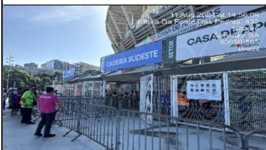
Figura 162: Catracas Acesso Sul
