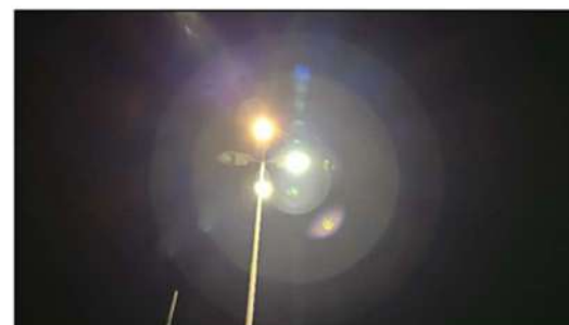
Figura 223: Inconformidade - Poste com luz apagada Estacionamento EE
