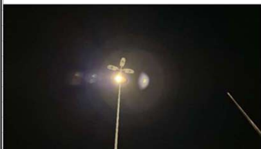
Figura 212: Inconformidade - Poste com luz apagada - Estacionamento EE
