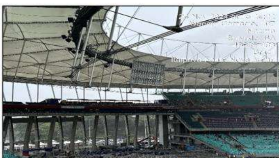
Figura 178: Inconformidade Telão Sul
