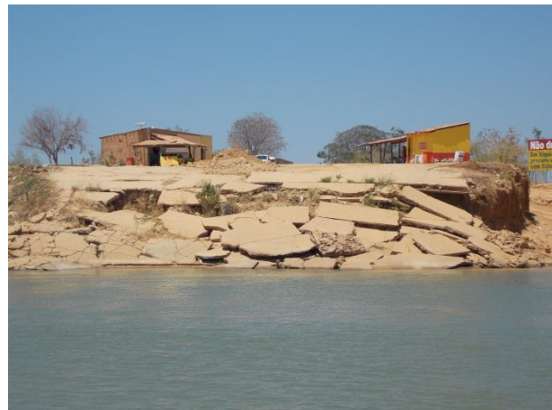
Vista frontal do local previsto para a implantação da ponte da alternativa de traçado 1, lado de Xique-Xique.
