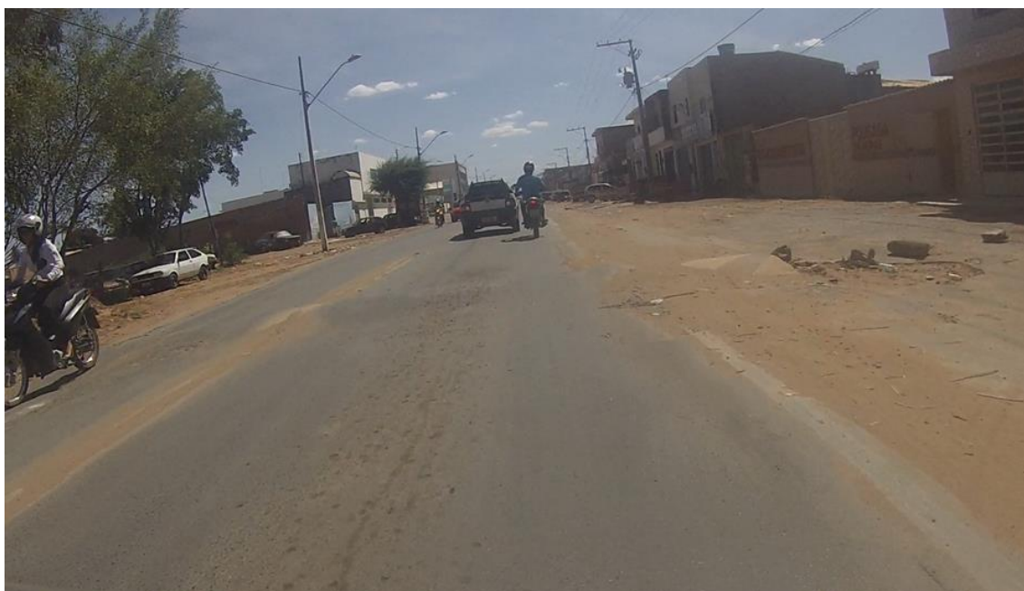
Figura 44 - km 0+000 ao 4+900: Trecho urbano, sinalização horizontal desgastada/ inexistente no local da lombada e no resto da via
