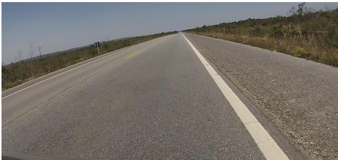
Figura 24 – km 255+000 ao km 260+000 (km 257+200): Trecho rural, sinalização horizontal visível, sinalização vertical insuficiente, placas novas.
