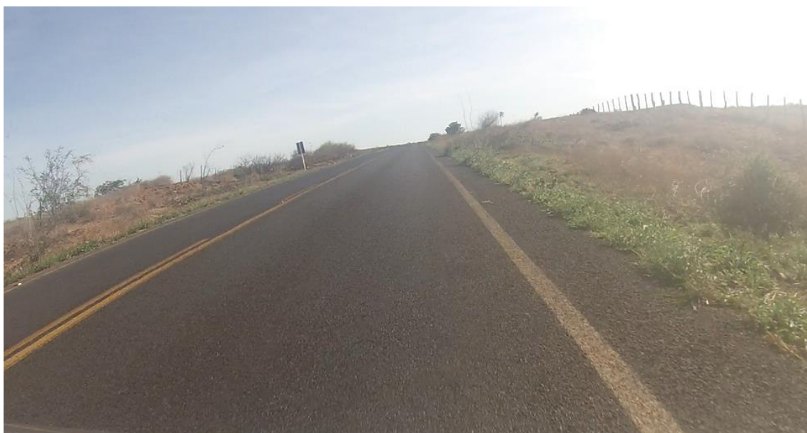
Figura 48 - km 44+000 ao trecho 56+000 (km55+100): Trecho rural, sinalização em bom estado, faixa horizontal nítida.
