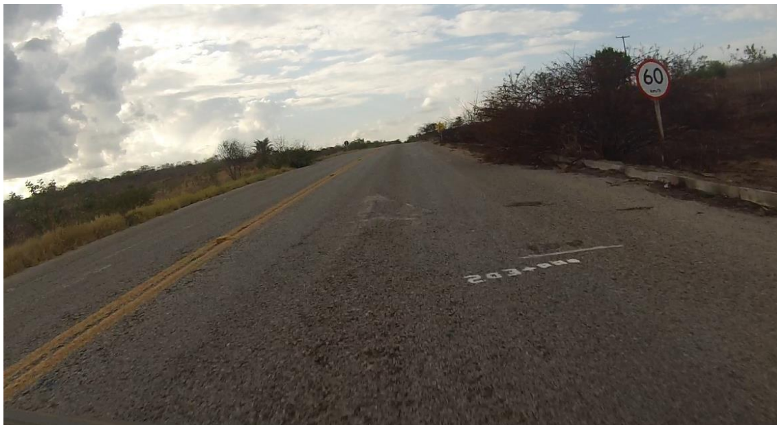
Figura 22 - km 202+000 ao km 205+000 (km 203+000): Trecho rural, sinalização horizontal deteriorada quase inexistente, buracos na via.
