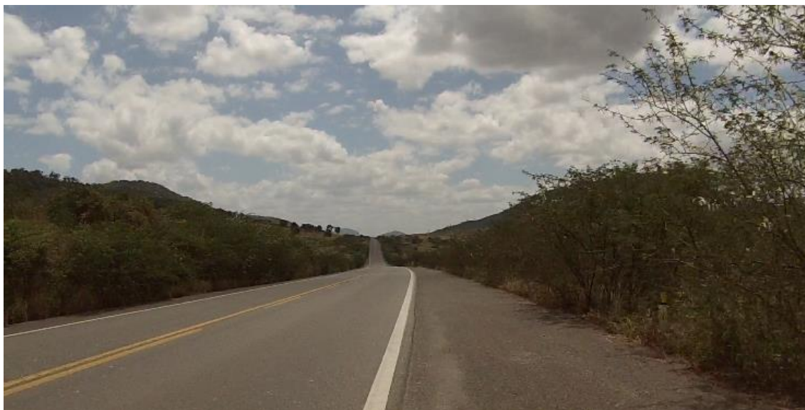
Figura 6 - km 21+000 ao km 27+500 (km 21+000): Sinalização em bom estado, faixa horizontal nítida.
