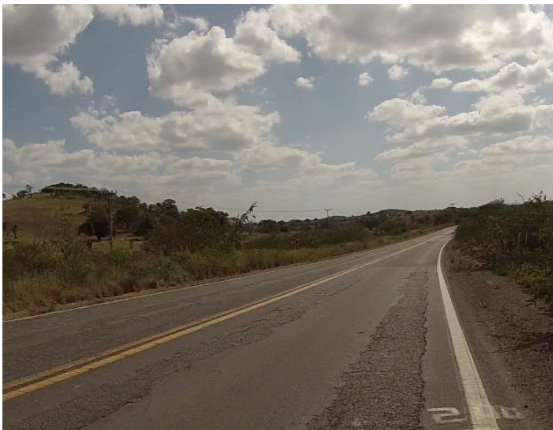
Figura 8 - km 41+400 ao km 51+000 :Pintura nítida, porém do km 42 ao km 46 existem muitos pontos com buracos, obrigando o motorista em alguns momentos a quase parar o veículo para conseguir transpor o mesmo.
