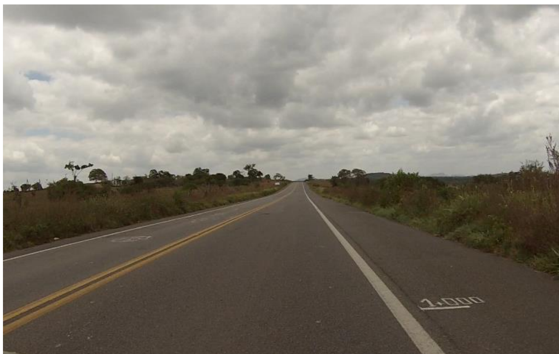
Figura 2 - km 0+500 ao km 11+500 (km 1+000): Trecho com pintura horizontal nítida
