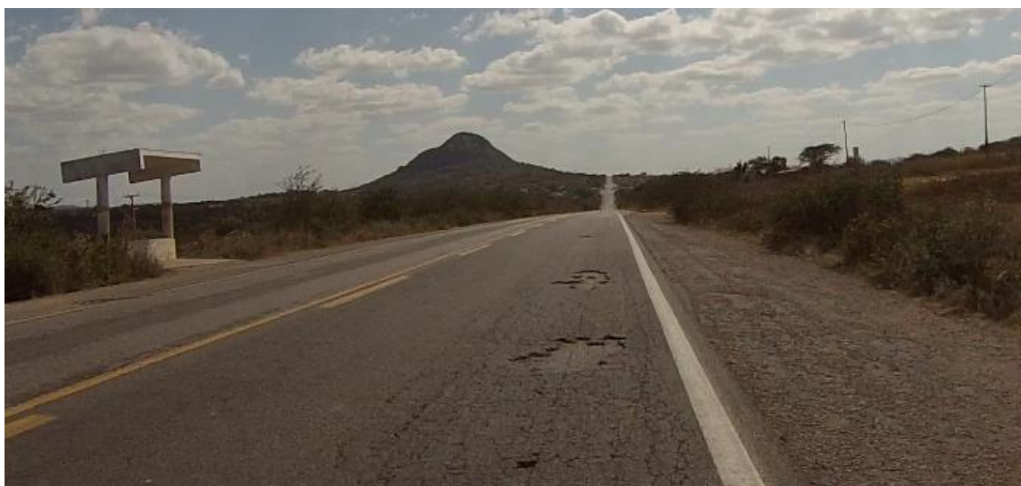
Figura 8 - km 41+400 ao km 51+000 :Pintura nítida, porém do km 42 ao km 46 existem muitos pontos com buracos, obrigando o motorista em alguns momentos a quase parar o veículo para conseguir transpor o mesmo.
