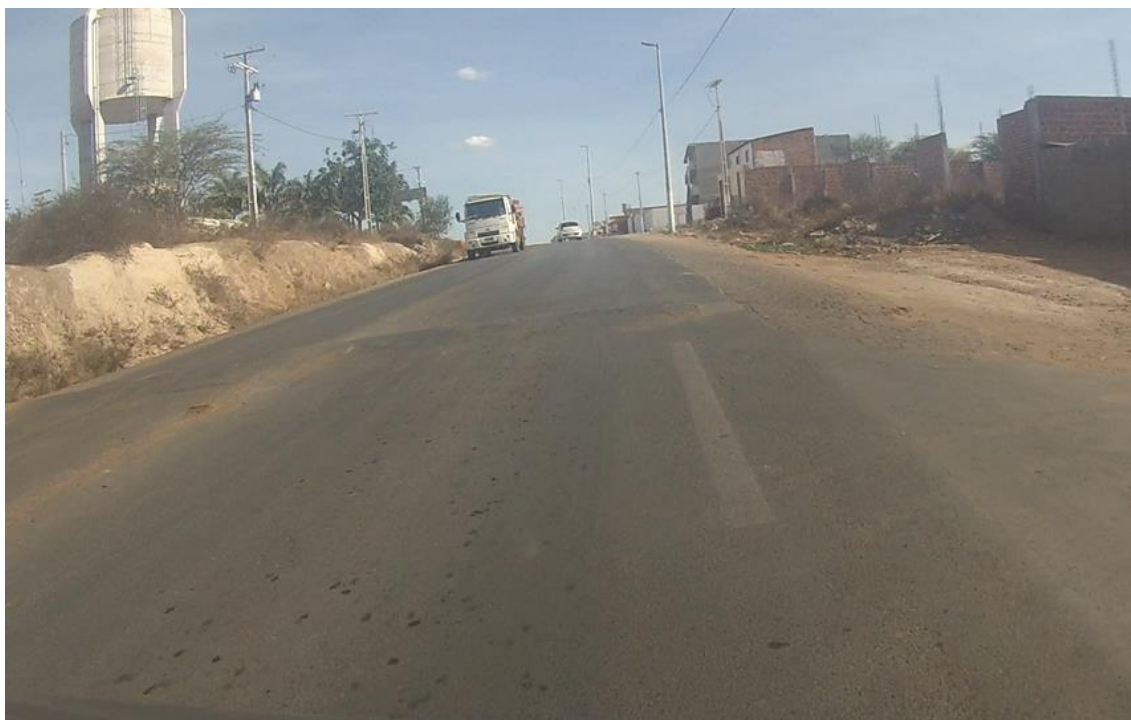
Figura 47 - km 42+200 ao 44+000 (km 42+200): Trecho urbano, sinalização horizontal ruim, desgastada e sem indicação de lombada.
