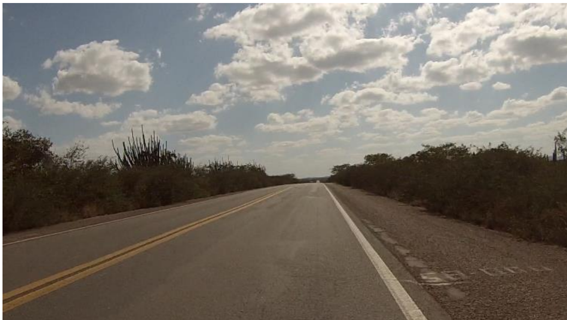
Figura 10 - km 53+000 ao km 86+000 (km 58+000): Sinalização em bom estado, faixa horizontal nítida.
