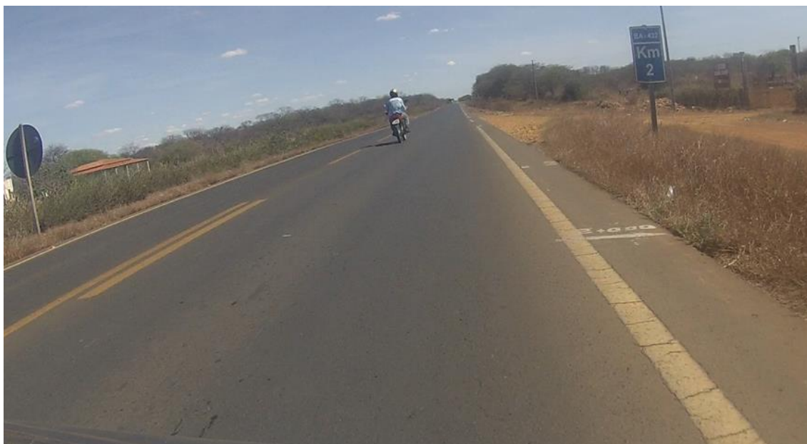
Figura 45 - km 0+000 ao 5+600 (km 2+000): Trecho rural, sinalização horizontal nitidamente visível.
