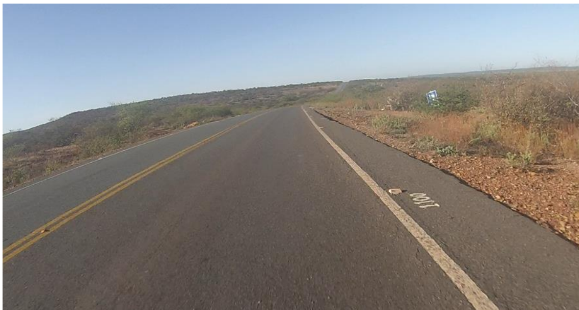
Figura 42 - km 61+500 ao 83+720 (km 62+100): Trecho rural, sinalização horizontal nitidamente visível, porém, a vegetação esta cobrindo parte da sinalização vertical.
