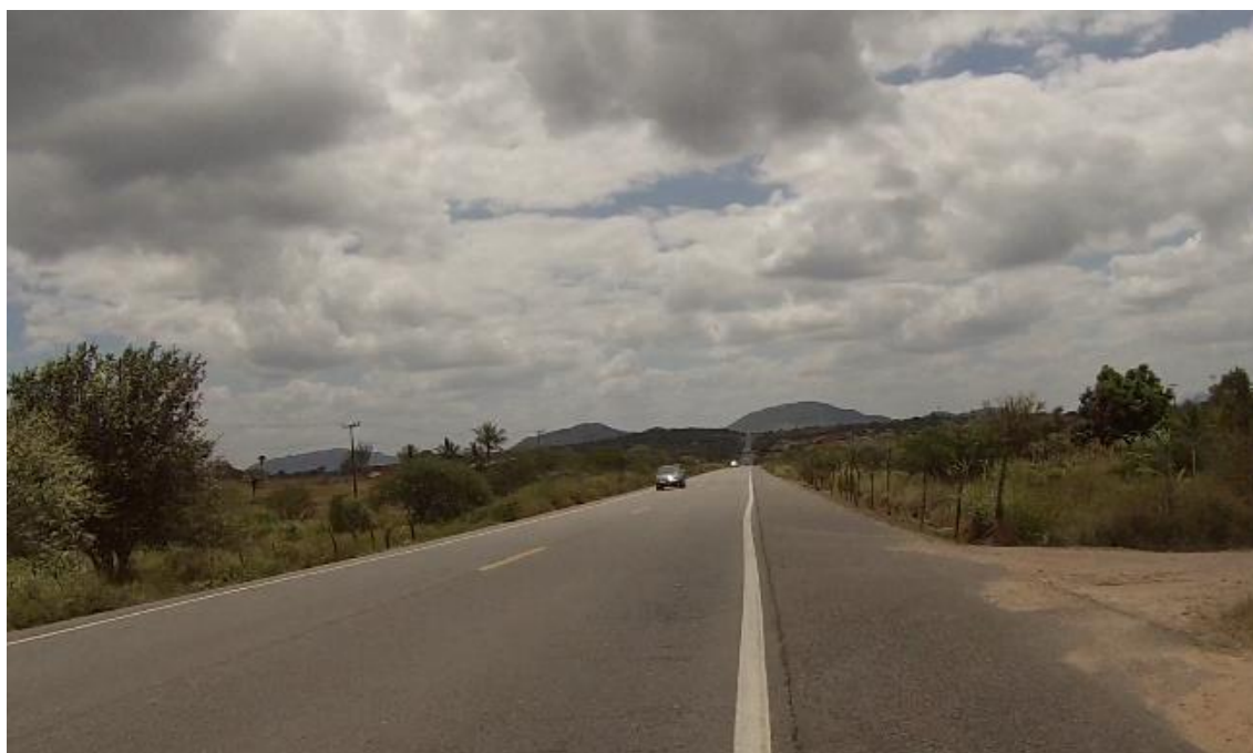
Figura 4 – km 13+000 ao km 15+500 (km14+000): Sinalização em bom estado, faixa horizontal nítida.
