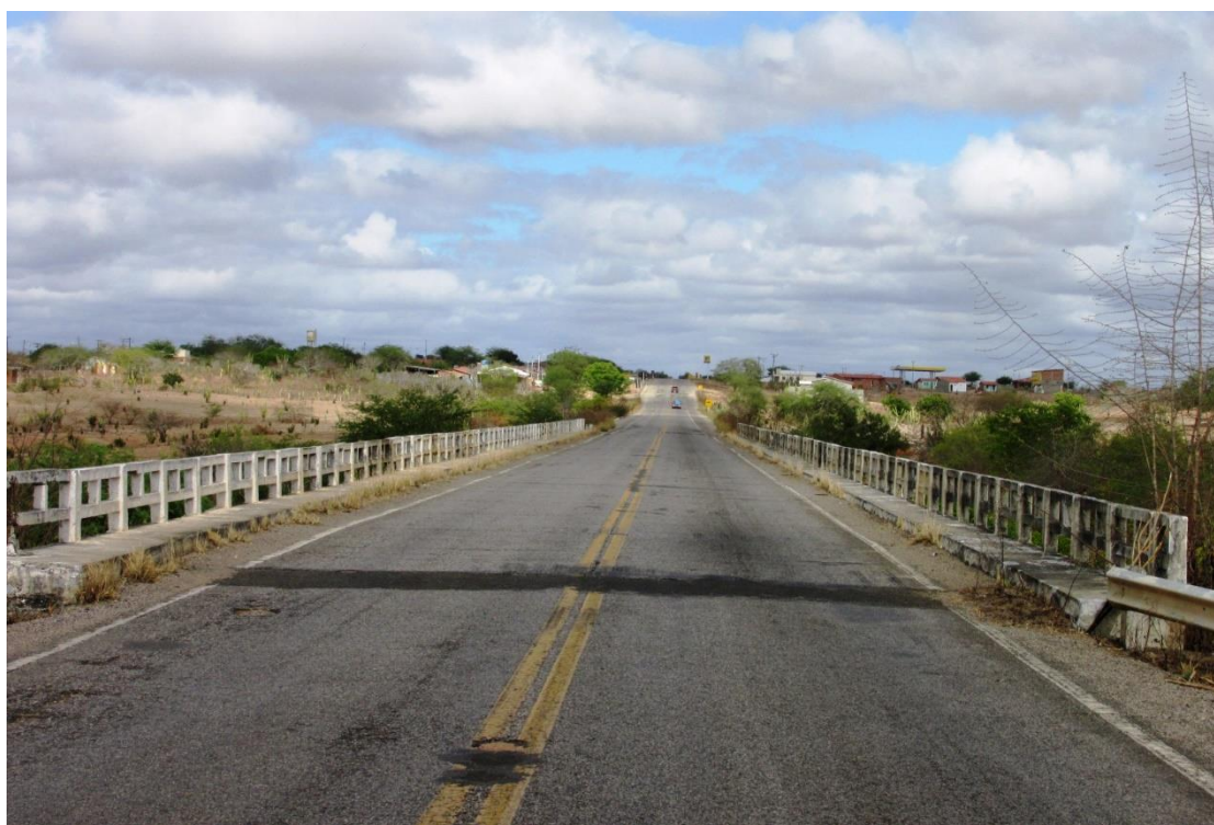
Figura 47 – Vista superior da OAE
