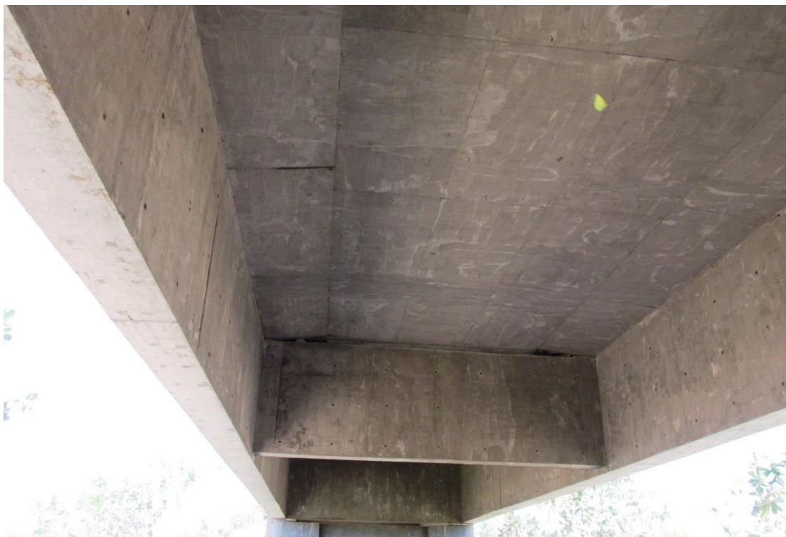
Figura 129 – Vista inferior da OAE
