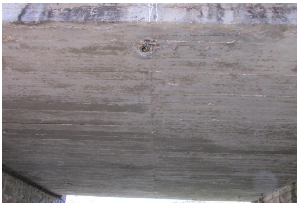
Figura 13 – Vista Inferior da OAE
