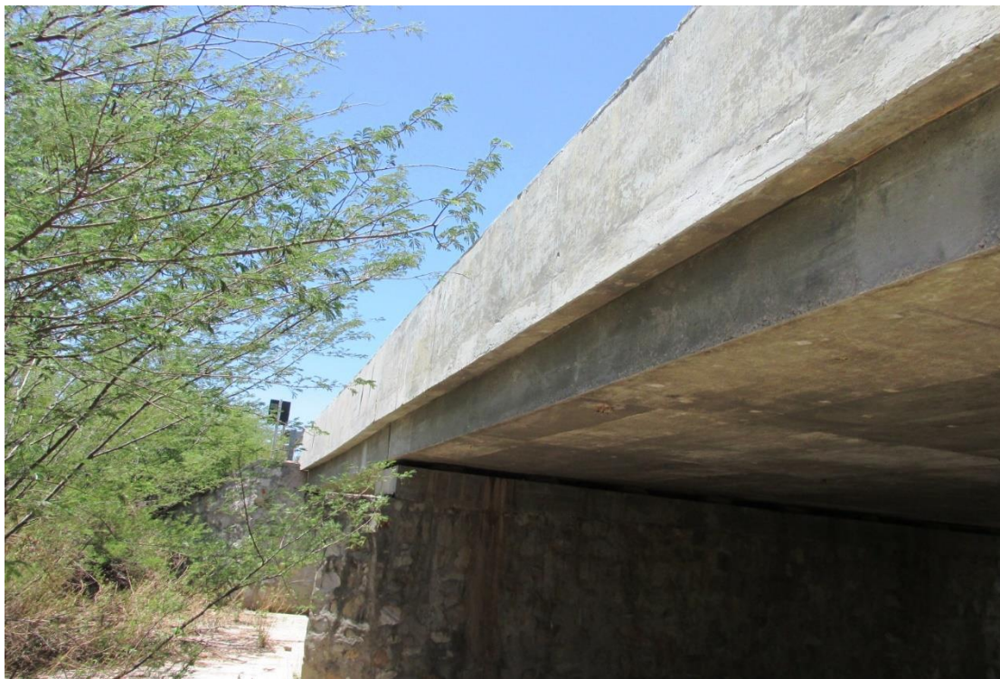
Figura 96 – Vista lateral da OAE
