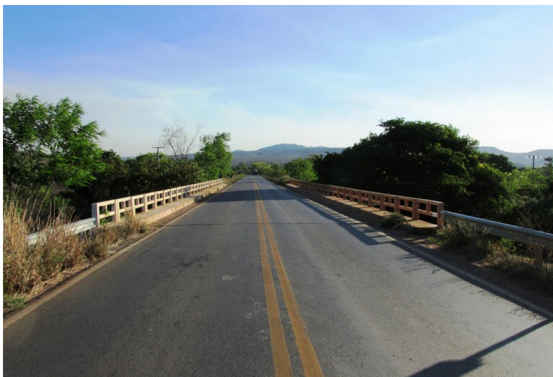
Figura 147 – Vista superior da OAE
