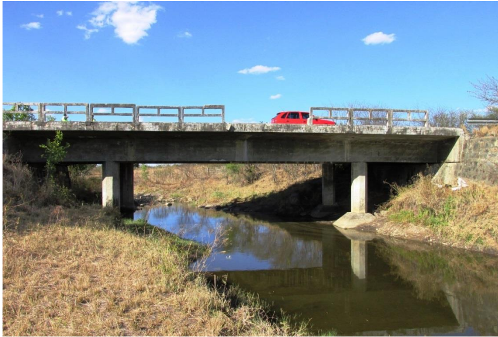
Figura 20 – Vista Lateral da OAE
