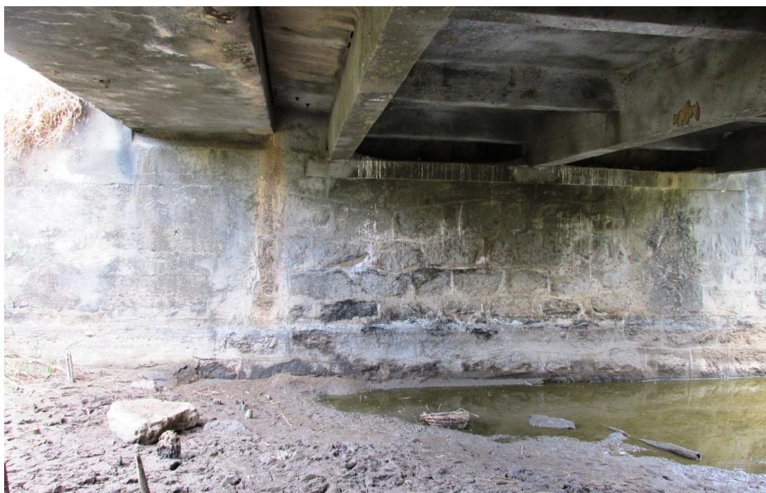
Figura 62 - Vista da mesoestrutura. Notar trecho de alargamento da obra.
