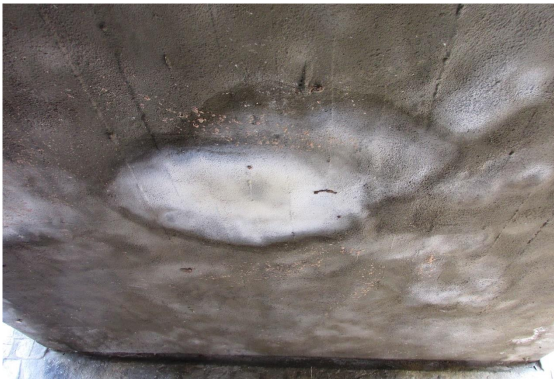
Figura 41 – Vista inferior da OAE
