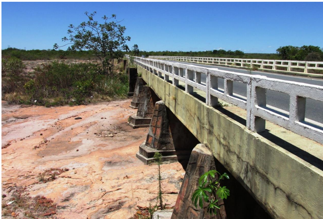
Figura 68 – Vista lateral da OAE
