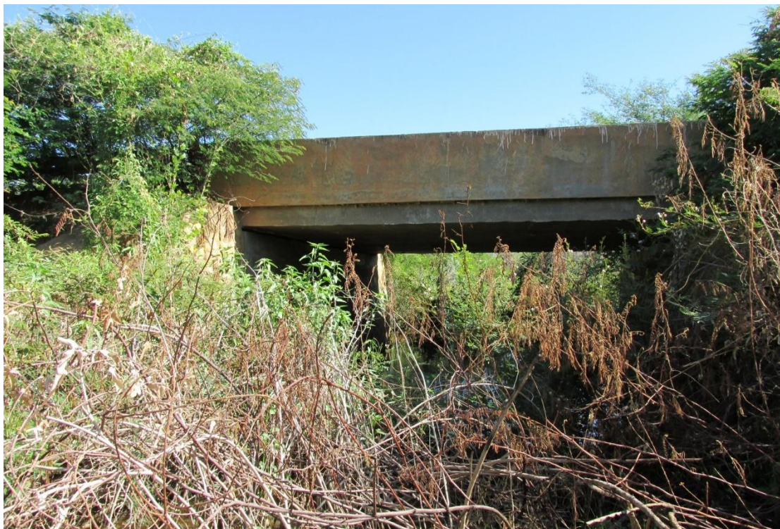
Figura 144 – Vista lateral da OAE
