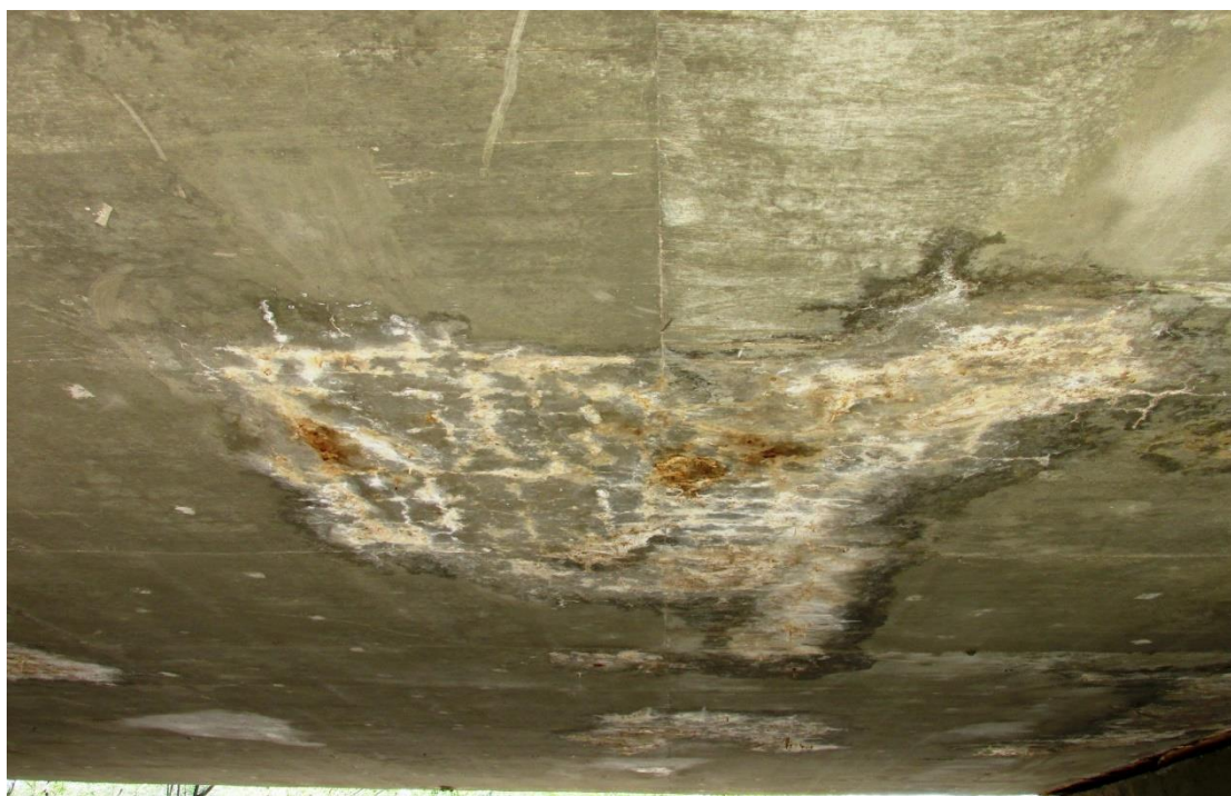
Figura 98 - Vista de manchas de eflorescência junto a superfície do tabuleiro.
