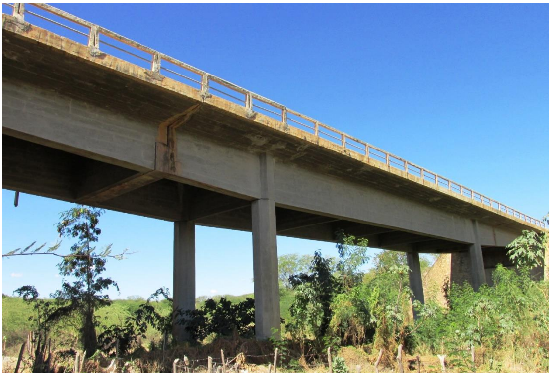
Figura 84 – Vista lateral da OAE
