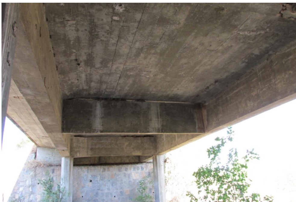
Figura 25 – Vista inferior da OAE
