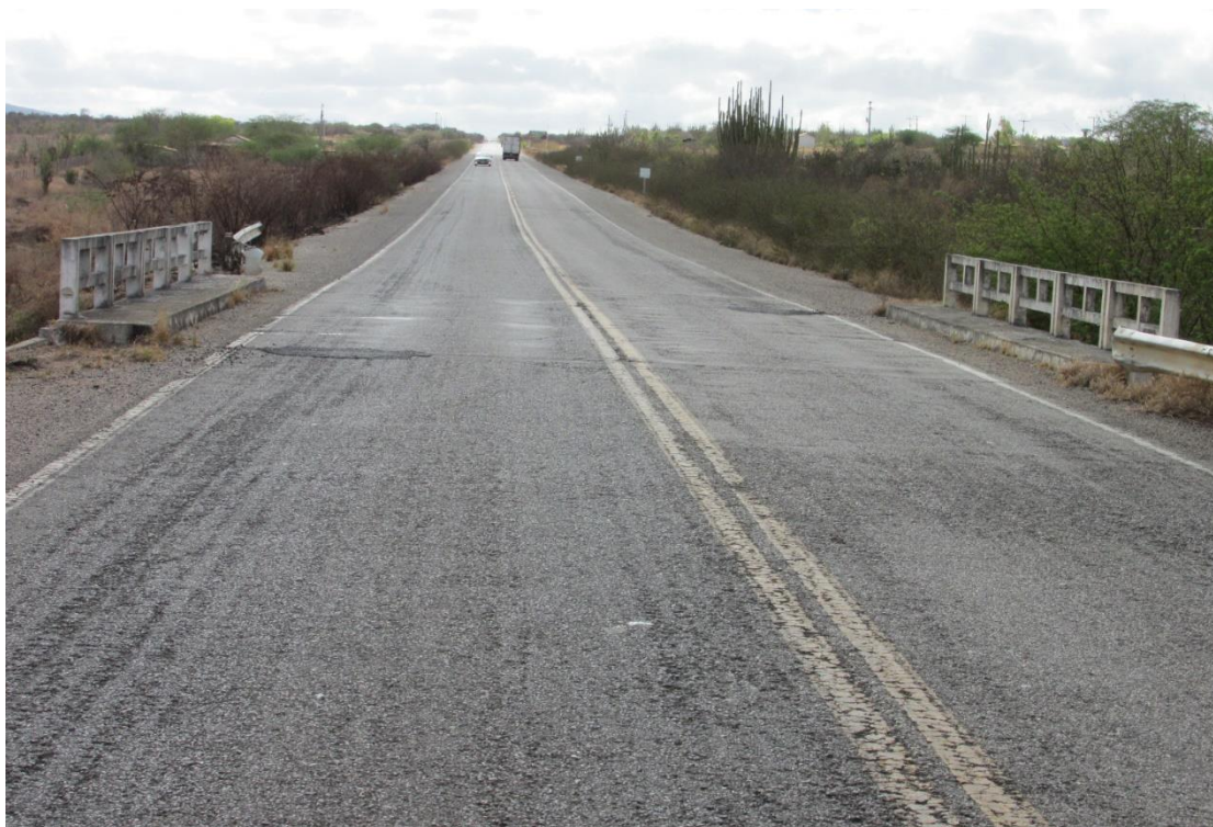
Figura 39 – Vista superior da OAE
