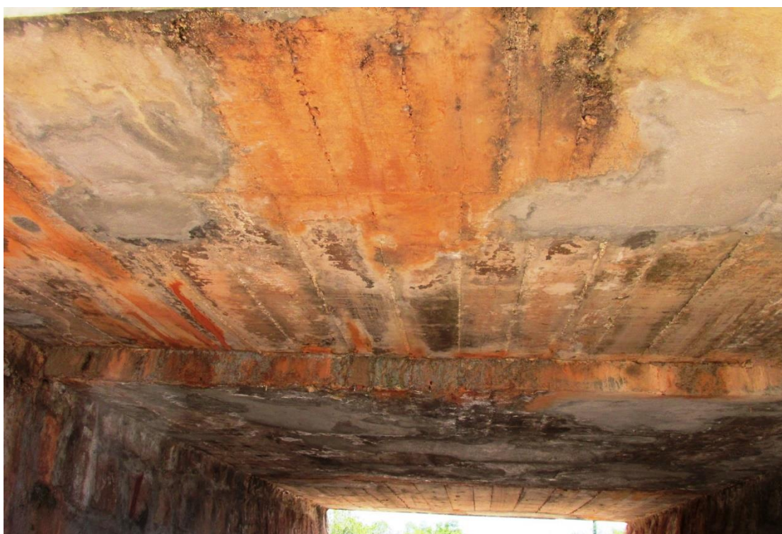
Figura 69 – Vista inferior da OAE
