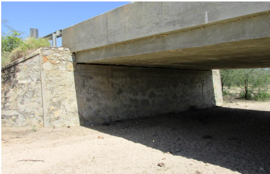
Figura 114 - Vista da estrutura de apoio da obra, em pedras argamassadas.
