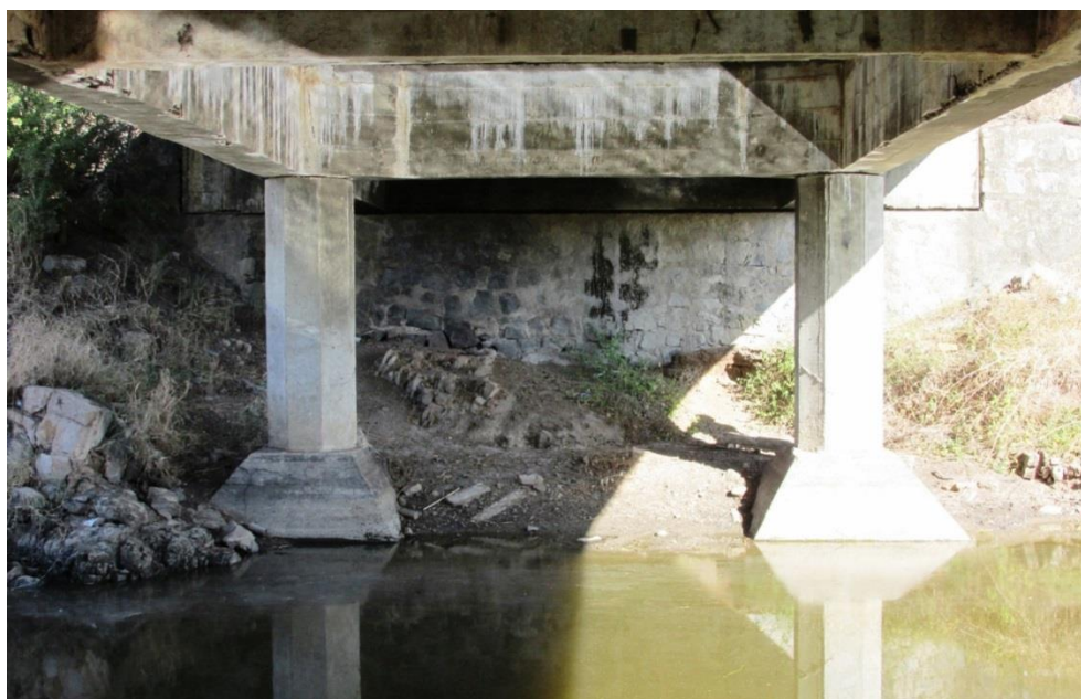
Figura 22 - Vista da linha de apoio junto ao encontro Sul da OAE
