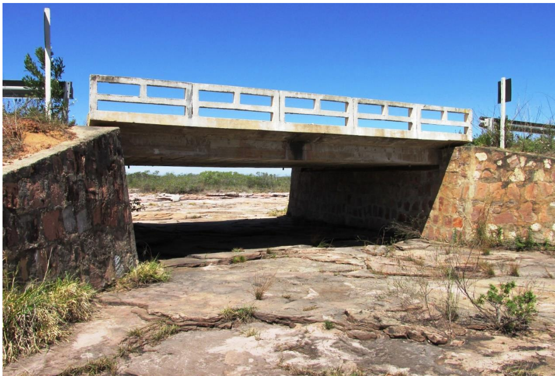
Figura 76 – Vista lateral da OAE
