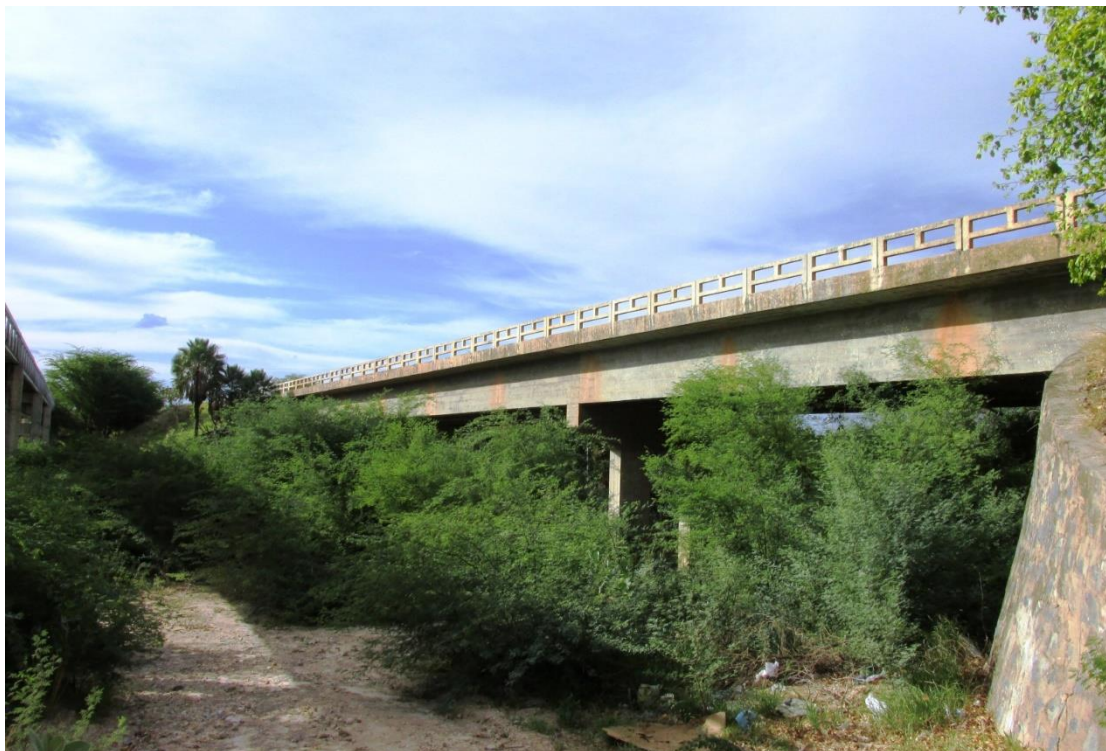
Figura 88 – Vista lateral da OAE
