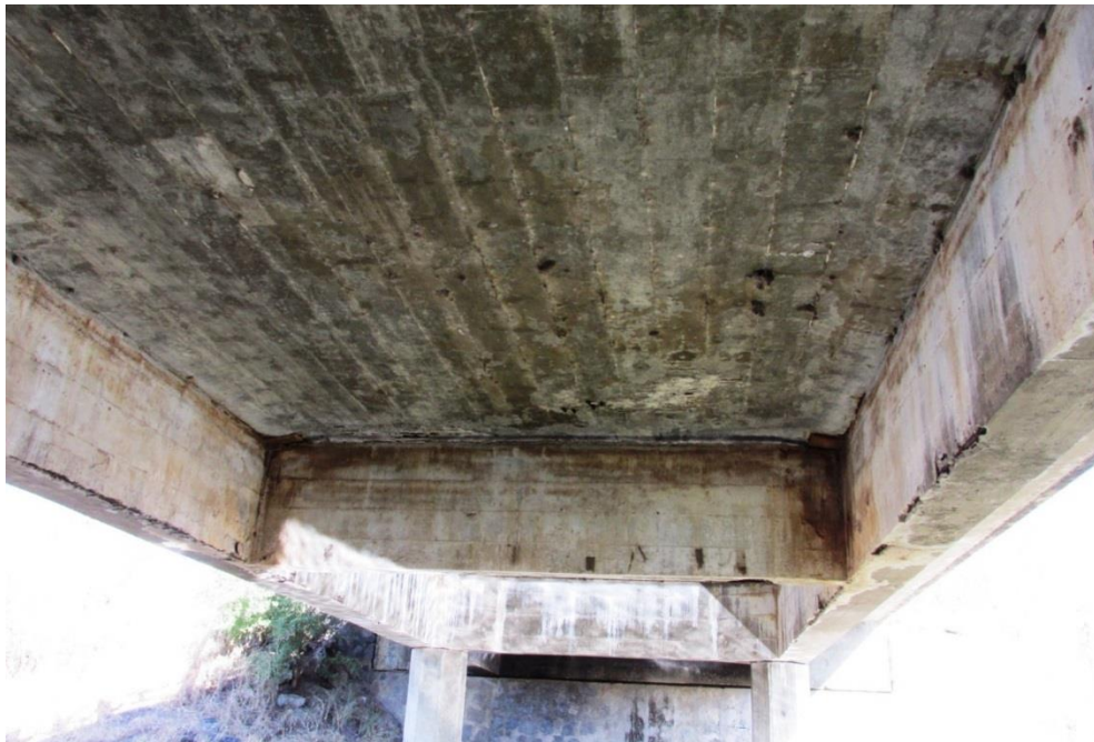
Figura 21 – Vista Inferior da OAE
