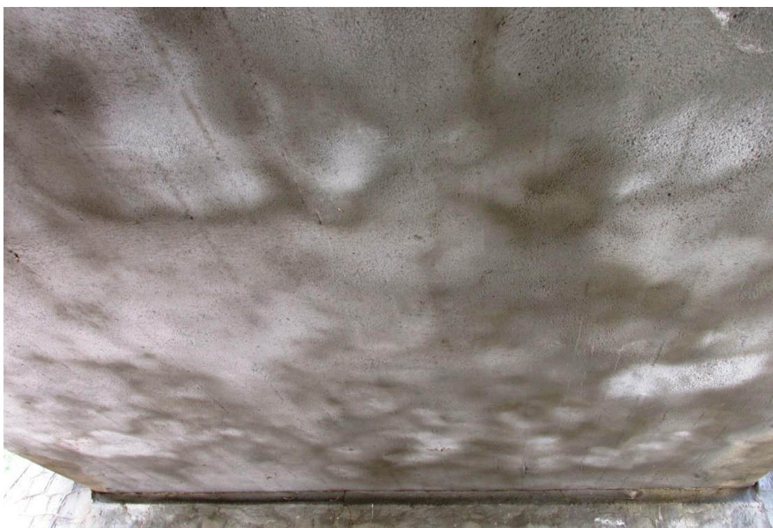
Figura 45 – Vista inferior da OAE
