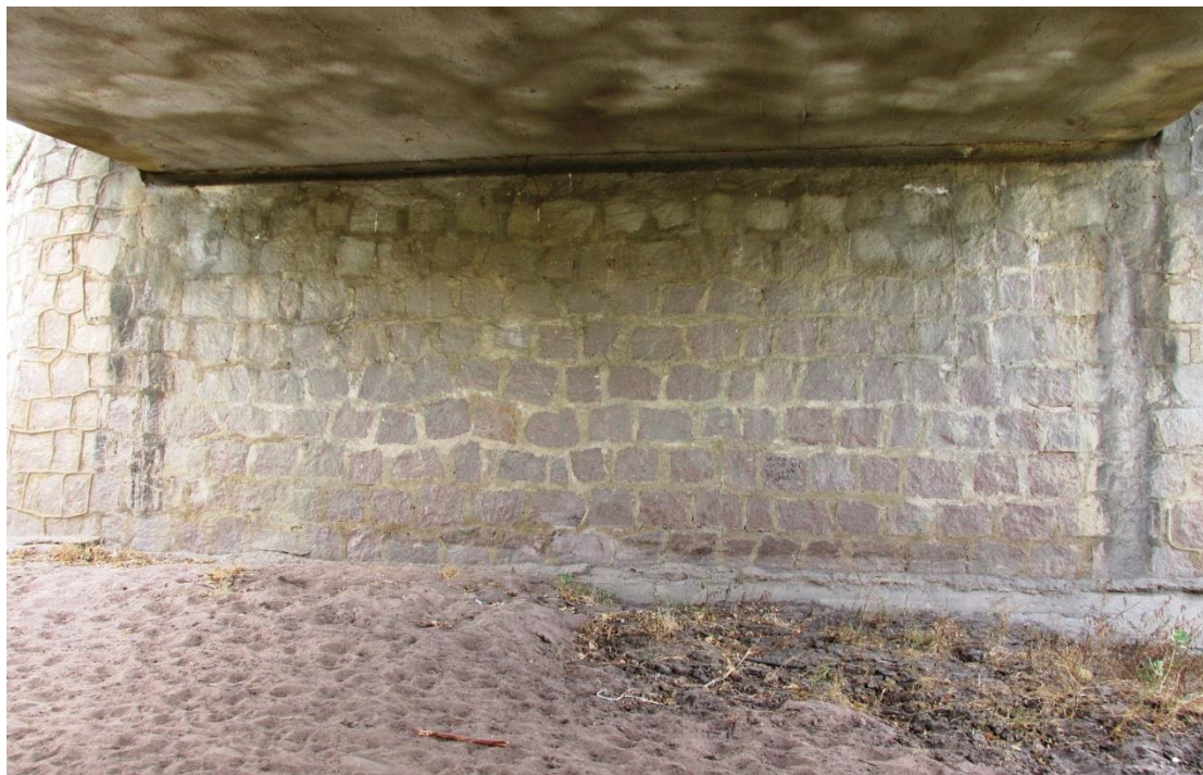
Figura 46 – Vista do pilar-parede da OAE.
