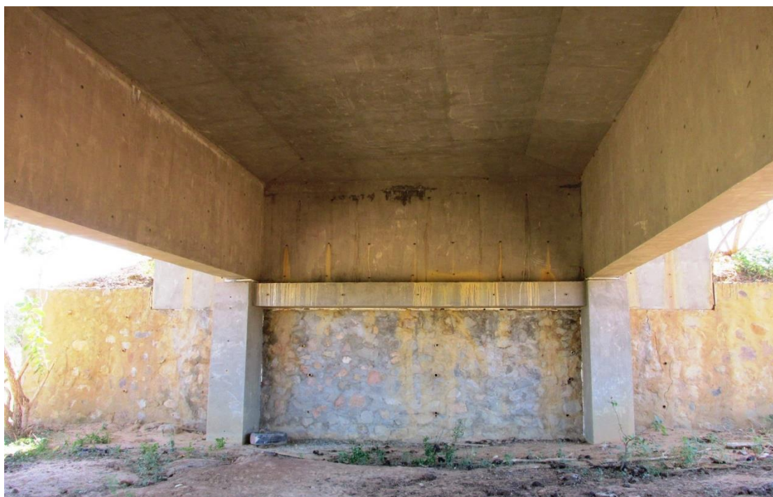
Figura 134 - Vista da estrutura de apoio da OAE.
