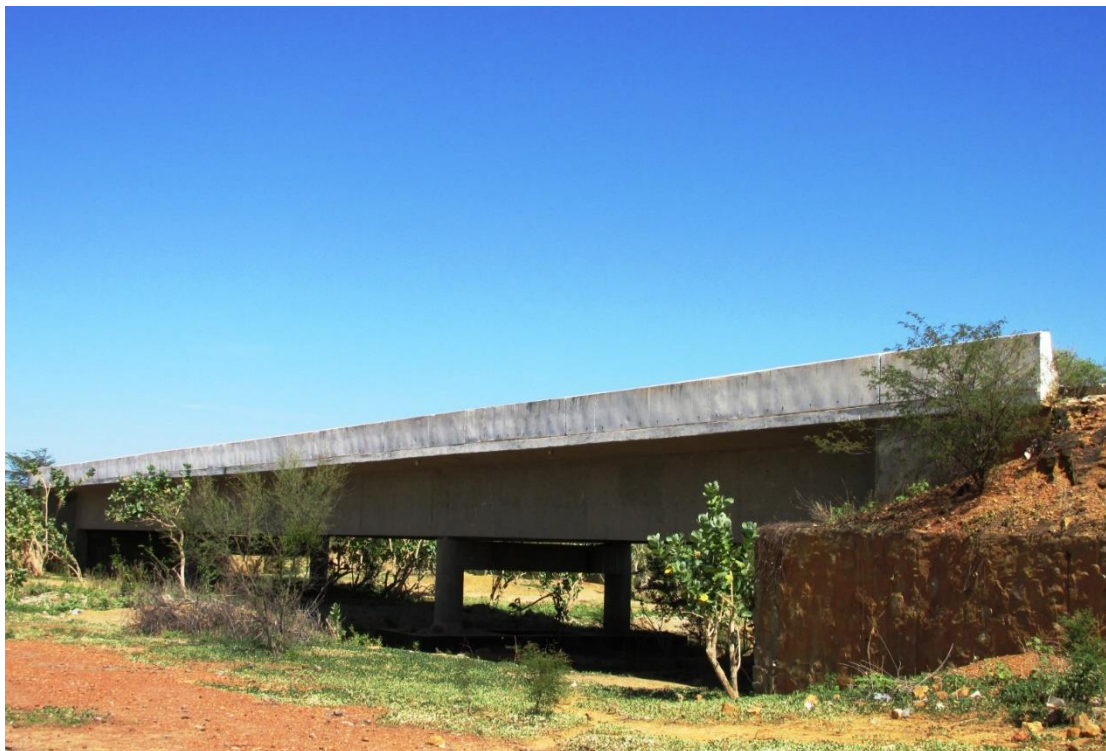
Figura 128 – Vista lateral da OAE
