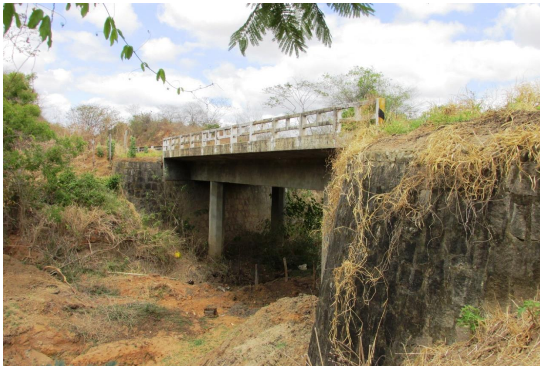
Figura 56 – Vista lateral da OAE
