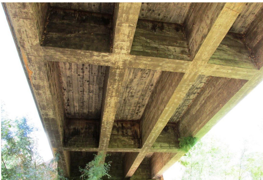
Figura 89 – Vista inferior da OAE
