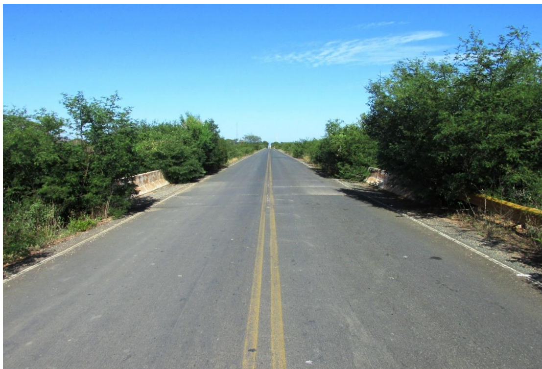
Figura 143 – Vista superior da OAE
