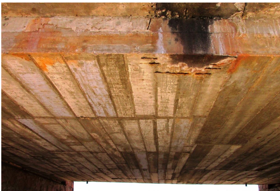
Figura 77 – Vista inferior da OAE
