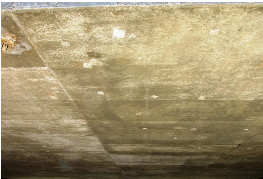
Figura 97 – Vista inferior da OAE
