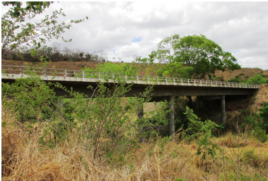
Figura 64 – Vista lateral da OAE
