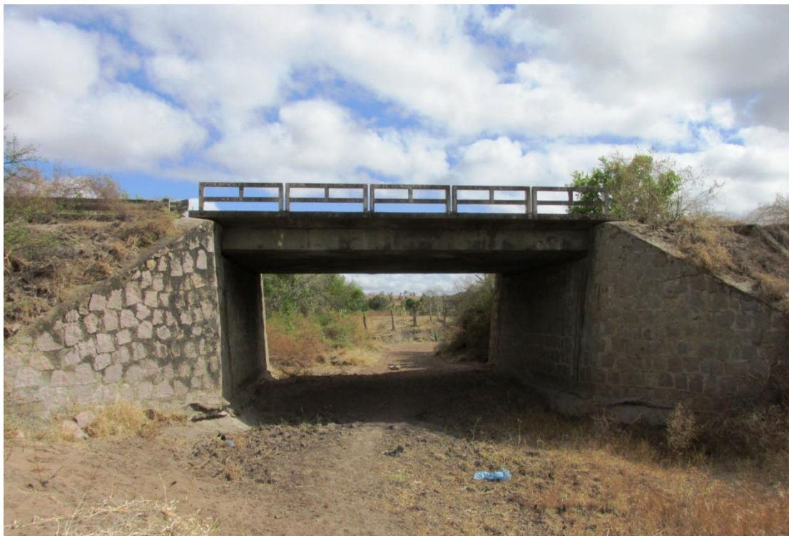
Figura 44 – Vista lateral da OAE
