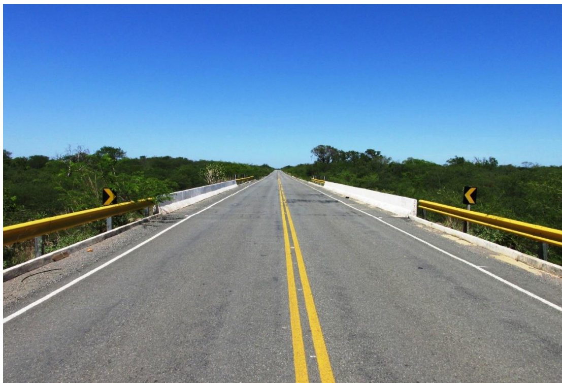
Figura 107 – Vista superior da OAE
