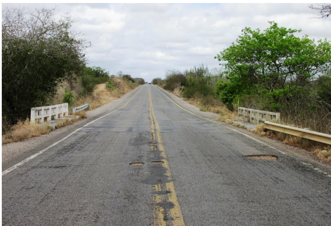
Figura 51 – Vista superior da OAE
