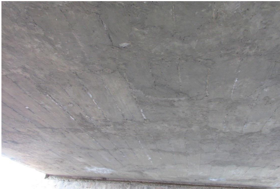
Figura 37 – Vista inferior da OAE
