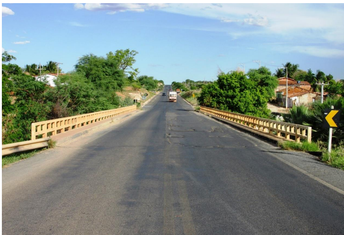
Figura 87 – Vista superior da OAE
