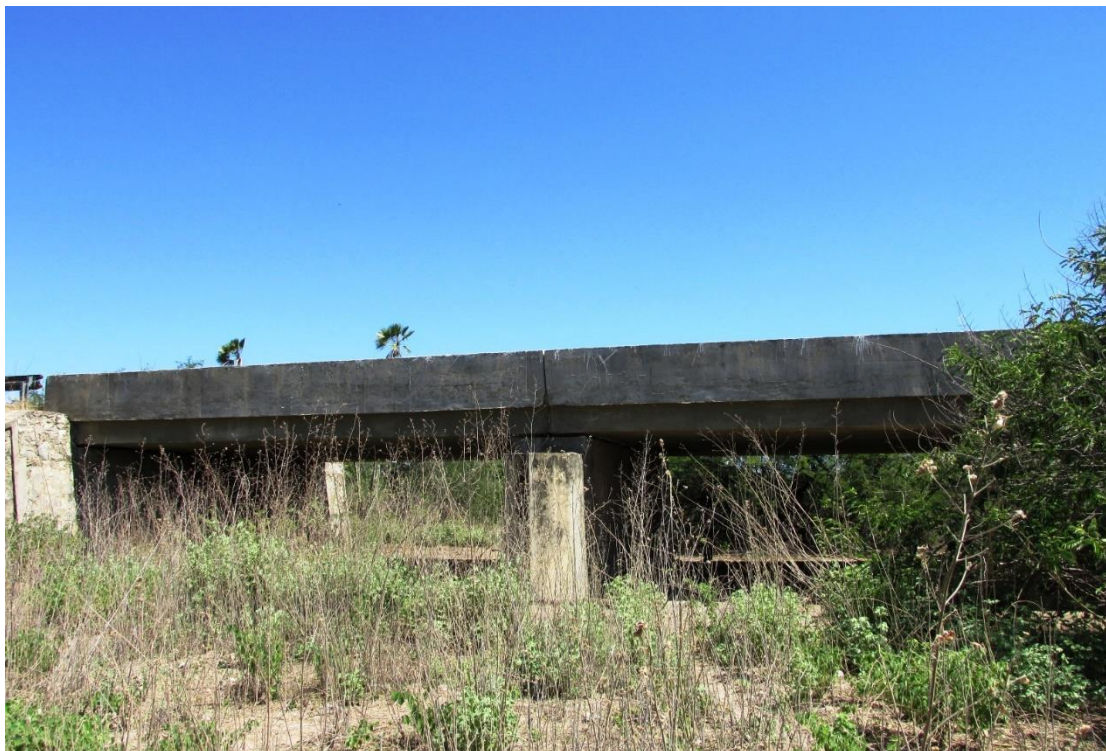
Figura 116 – Vista lateral da OAE
