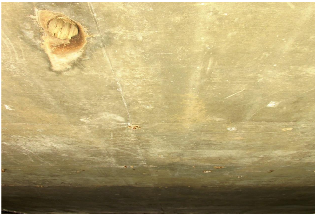
Figura 121 – Vista inferior da OAE
