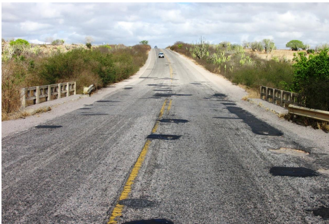
Figura 43 – Vista superior da OAE
