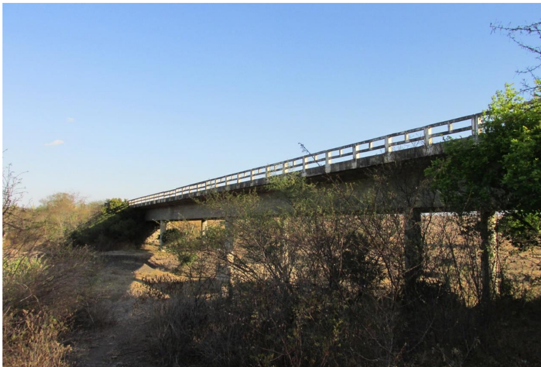
Figura 32 – Vista lateral da OAE
