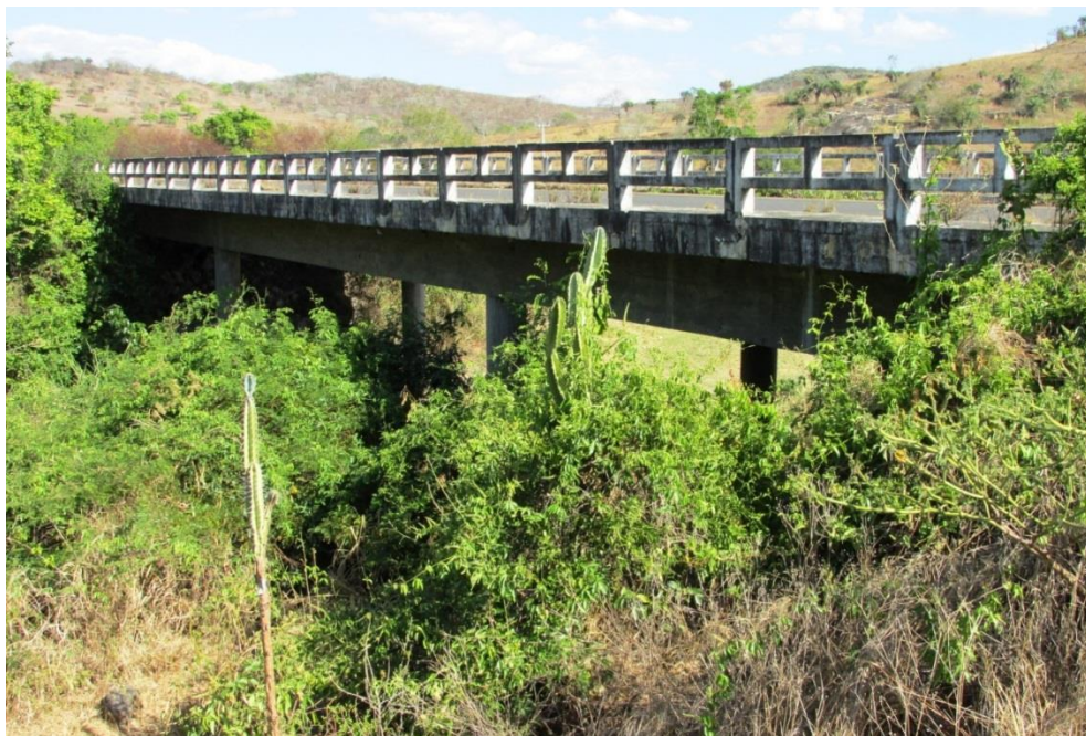
Figura 16 - Vista Lateral da Obra
