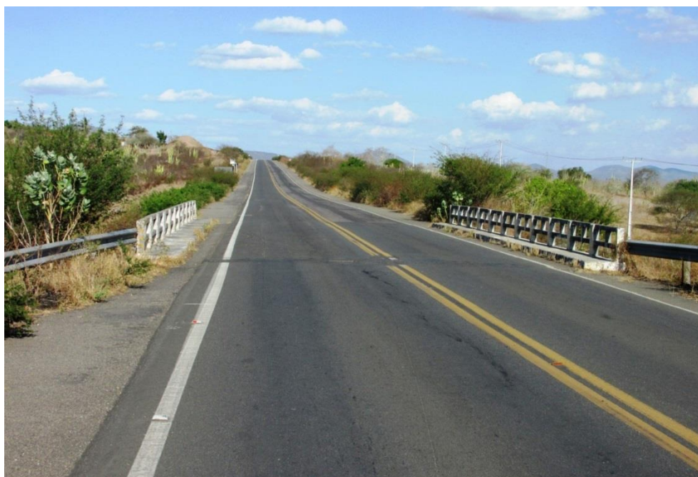
Figura 23 – Vista superior da OAE
