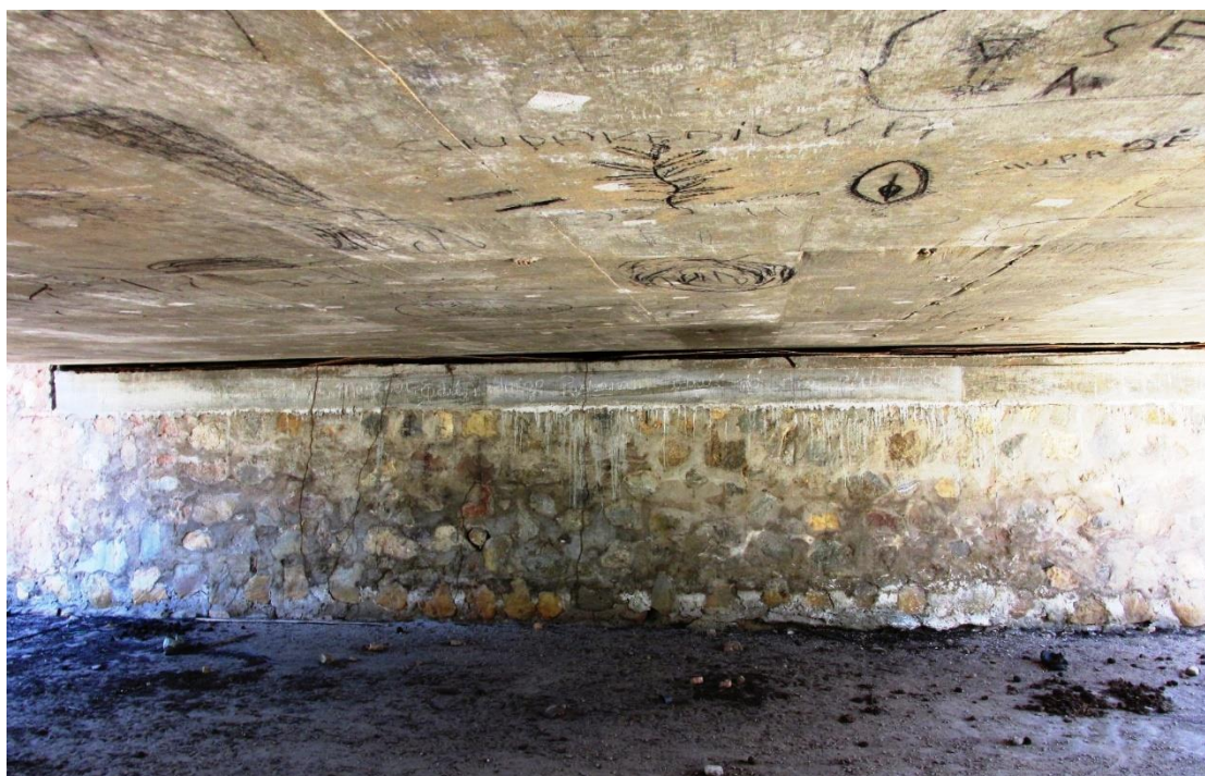
Figura 106 - Enfoque para linha de apoio em parede de base da superestrutura da OAE, em muro de pedras argamassadas.
