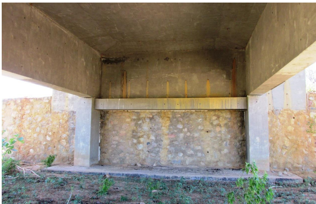
Figura 130 - Vista da mesoestrutura da obra.
