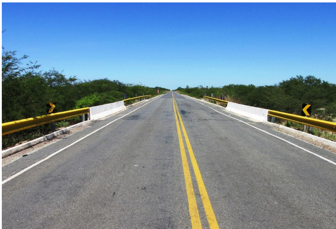
Figura 111 – Vista superior da OAE
