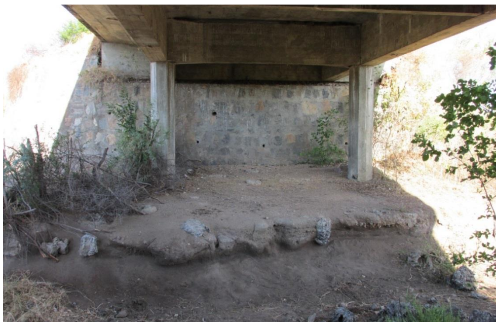
Figura 26 - Enfoque em linha de apoio e encontro da OAE
