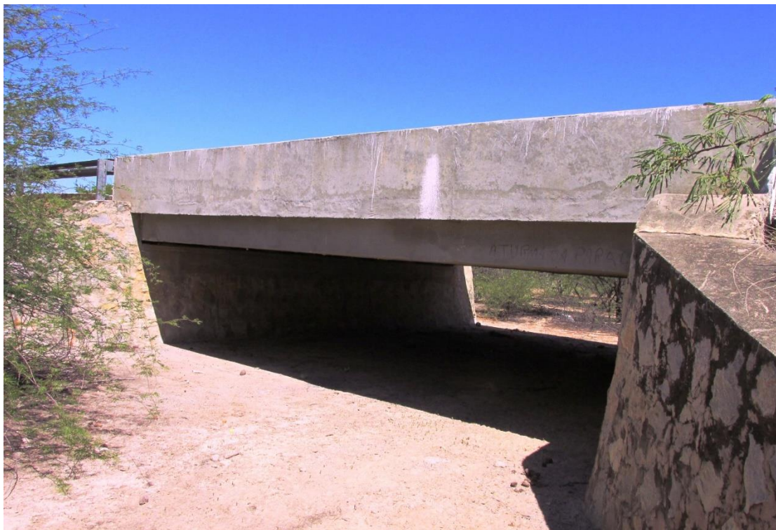
Figura 120 – Vista lateral da OAE
