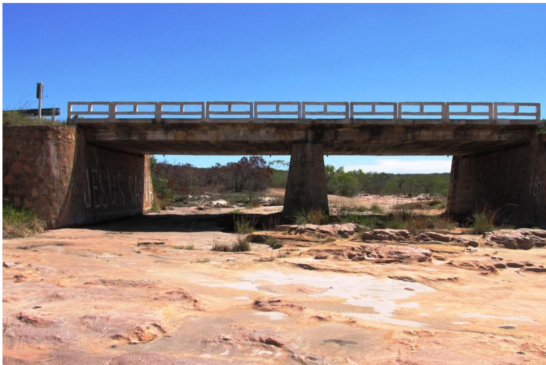
Figura 80 – Vista lateral da OAE
