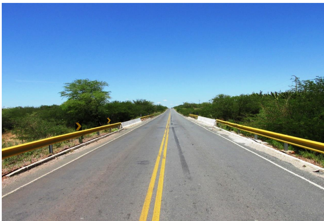
Figura 91 – Vista superior da OAE
