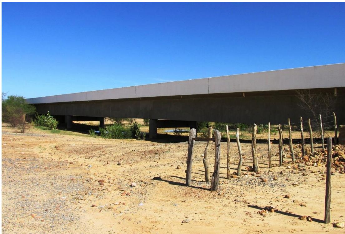
Figura 140 – Vista lateral da OAE
