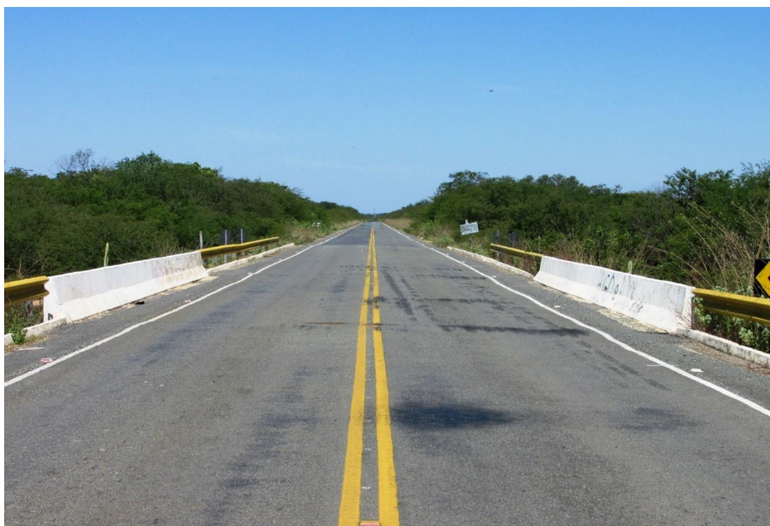
Figura 115 – Vista superior da OAE
