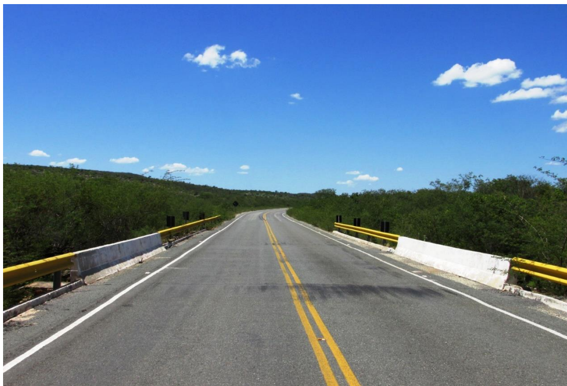
Figura 103 – Vista superior da OAE
