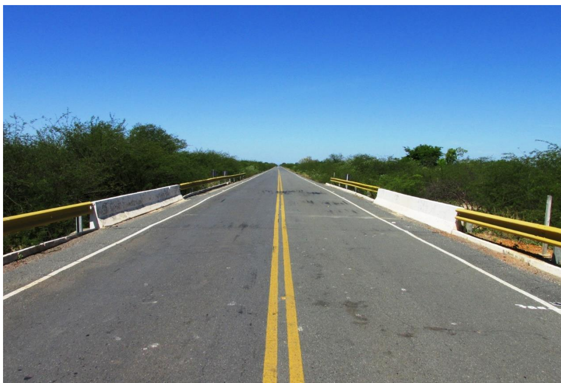
Figura 119 – Vista superior da OAE
