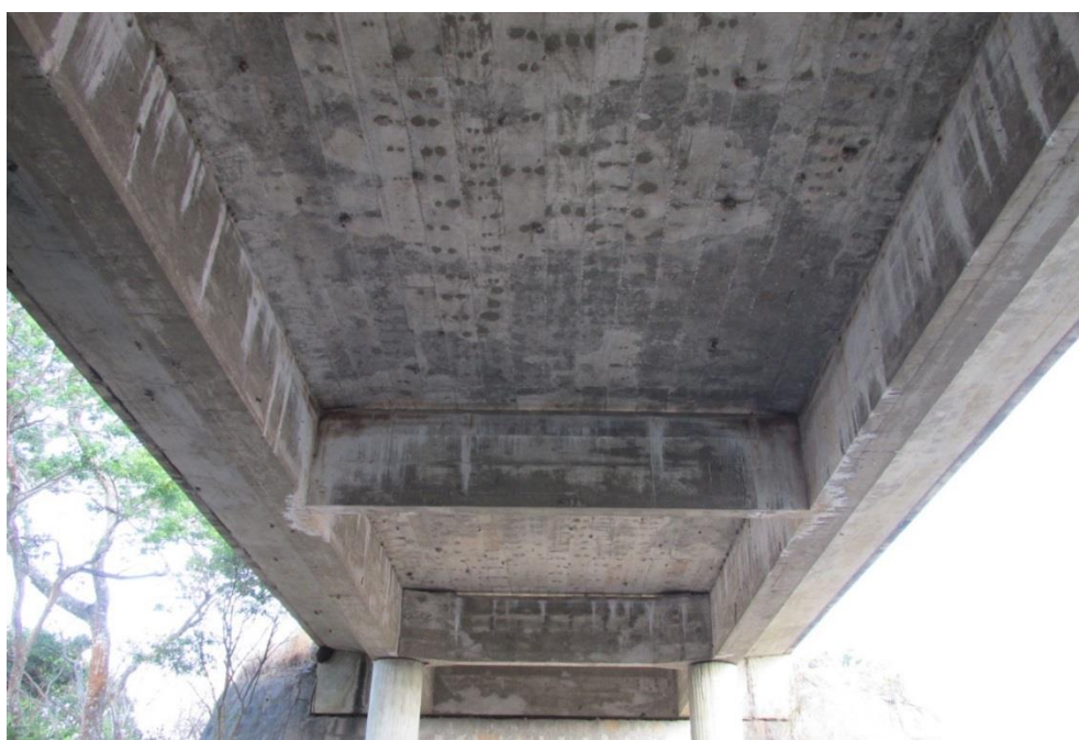
Figura 29 – Vista inferior da OAE
