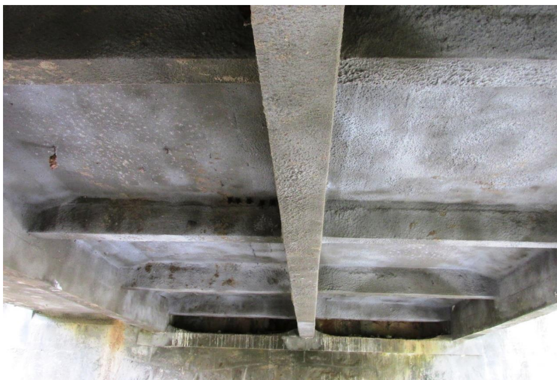
Figura 61 – Vista inferior da OAE
