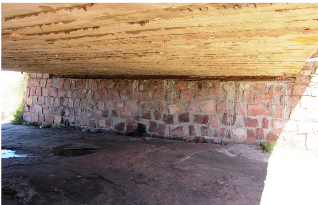
Figura 74 – Vista da mesoestrutura da OAE
