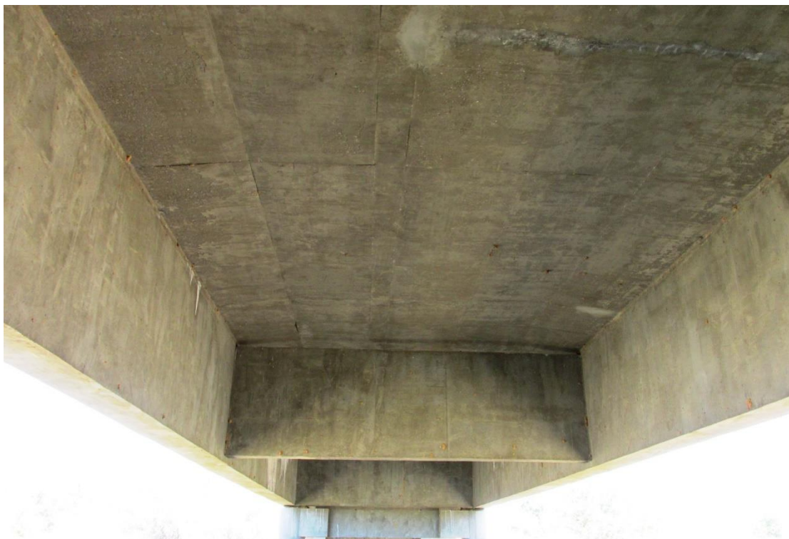
Figura 141 – Vista inferior da OAE
