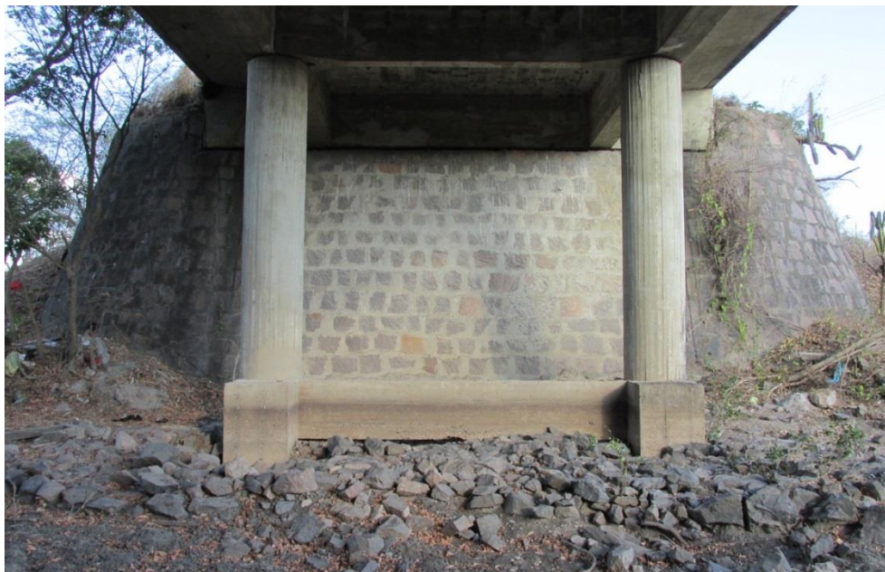
Figura 30 - Vista da linha de apoio junto ao encontro da OAE
