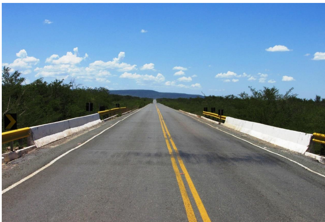
Figura 95 – Vista superior da OAE
