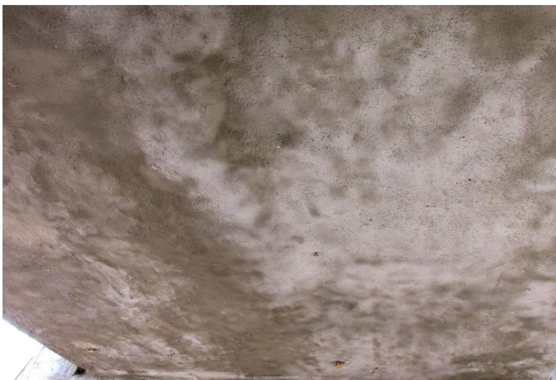
Figura 53 – Vista inferior da OAE
