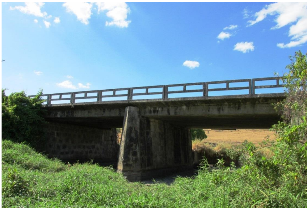
Figura 12 – Vista Lateral da OAE
