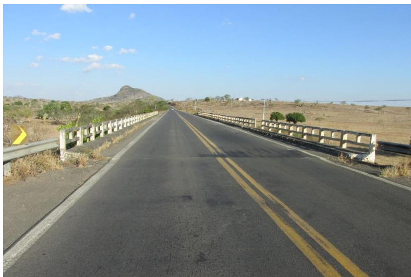
Figura 5 – Vista superior da OAE N°06 - km 57+300 - BA-052
