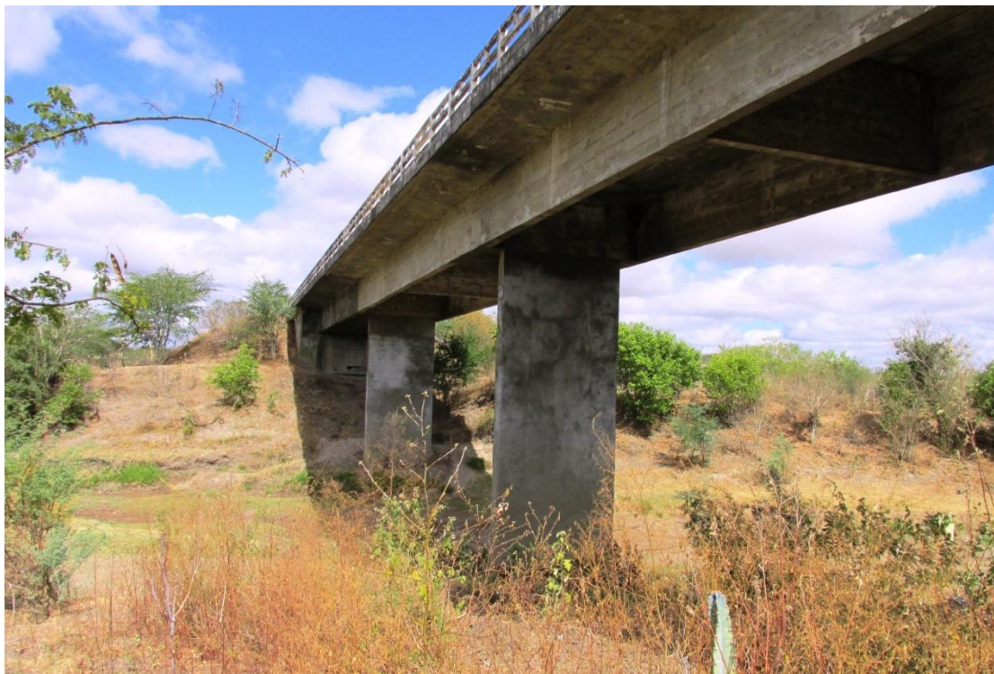
Figura 48 – Vista lateral da OAE
