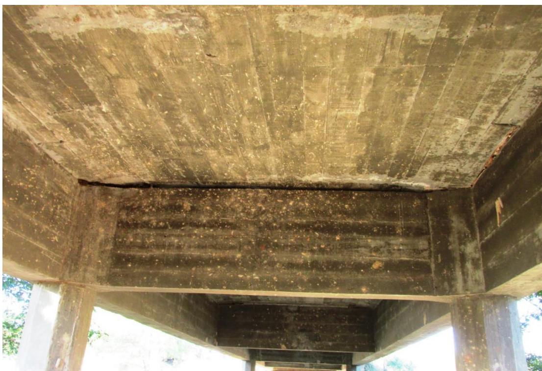
Figura 149 – Vista inferior da OAE
