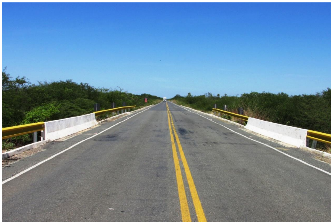
Figura 99 – Vista superior da OAE
