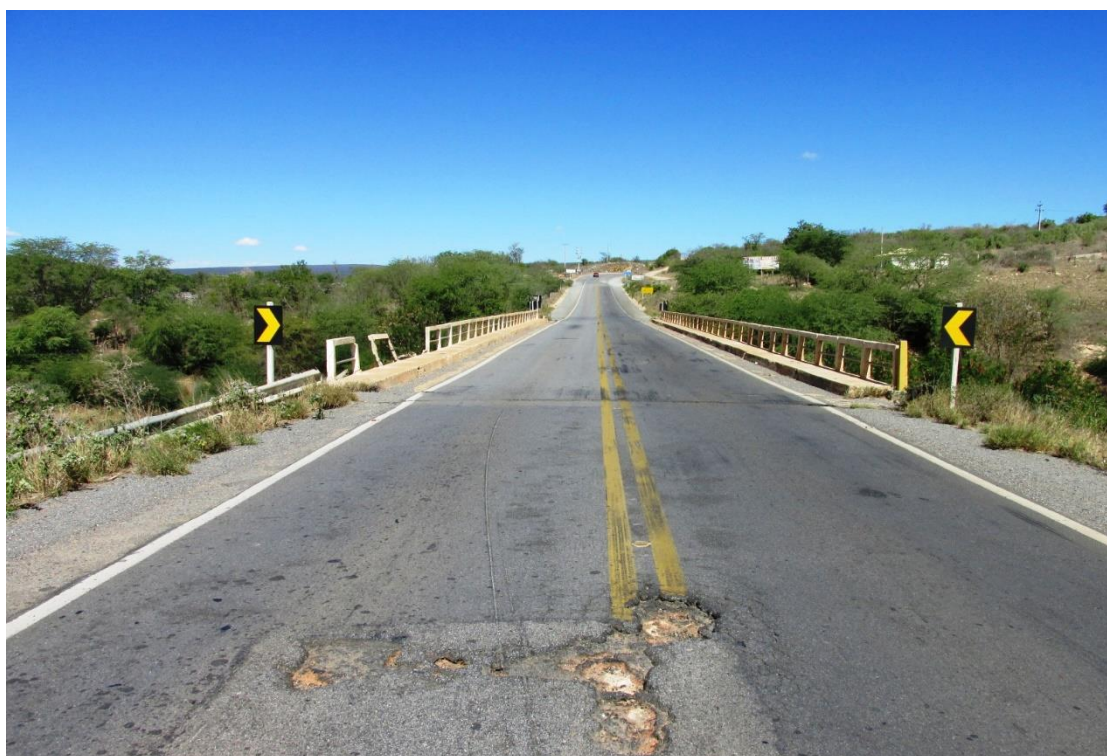
Figura 83 – Vista superior da OAE
