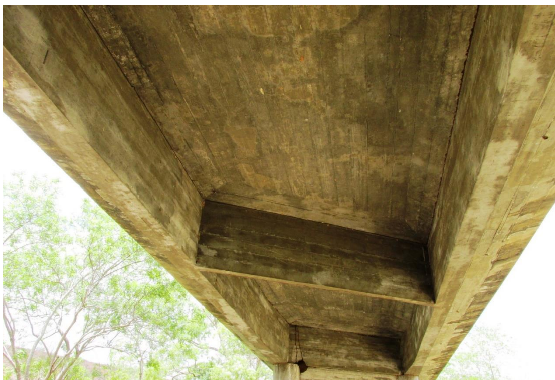
Figura 65 – Vista inferior da OAE
