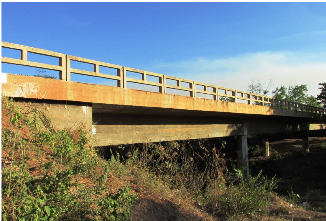
Figura 148 – Vista lateral da OAE
