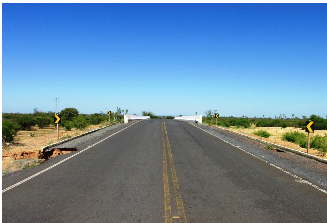
Figura 135 – Vista superior da OAE
