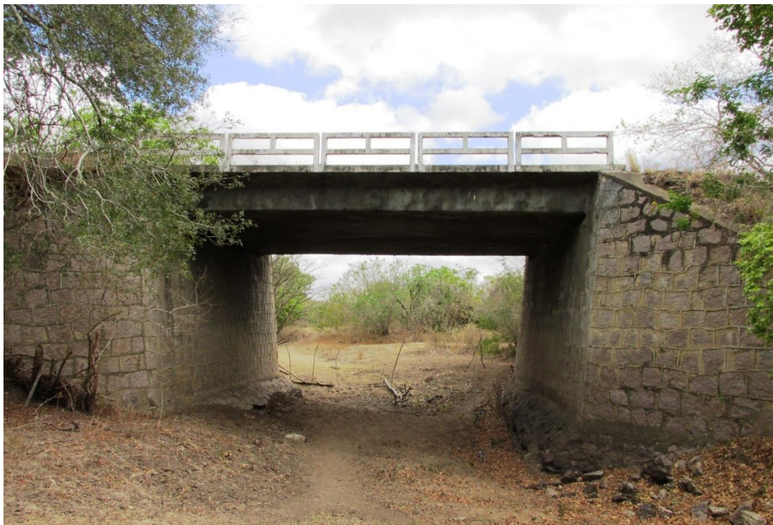
Figura 52 – Vista lateral da OAE
