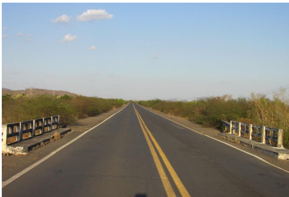
Figura 35 – Vista superior da OAE
