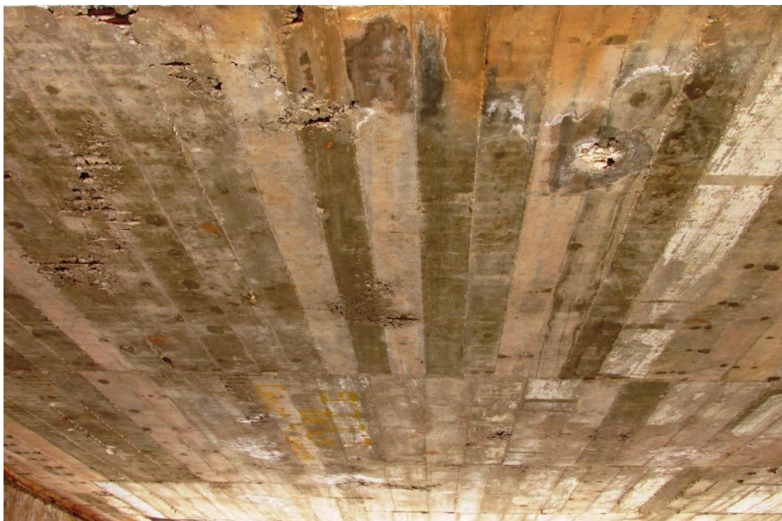
Figura 81 – Vista inferior da OAE
