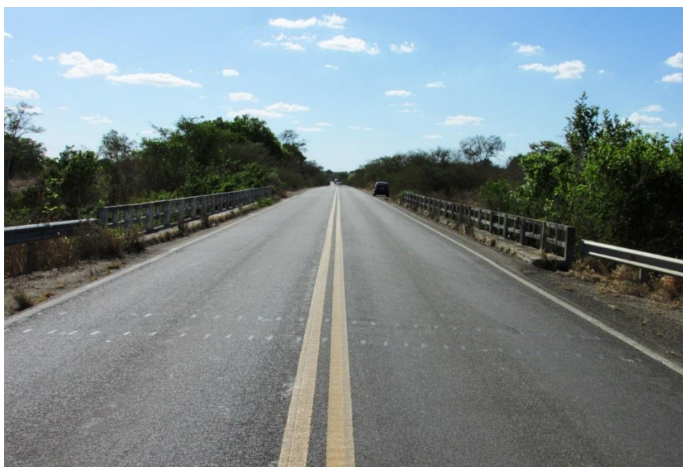
Figura 15 – Vista Superior da Obra
