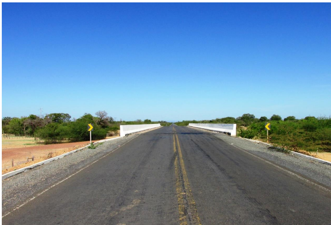
Figura 139 – Vista superior da OAE
