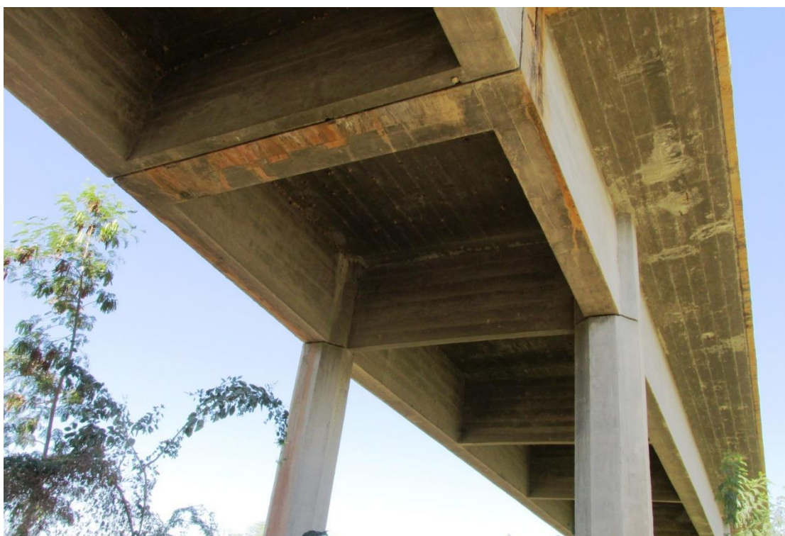
Figura 85 – Vista inferior da OAE
