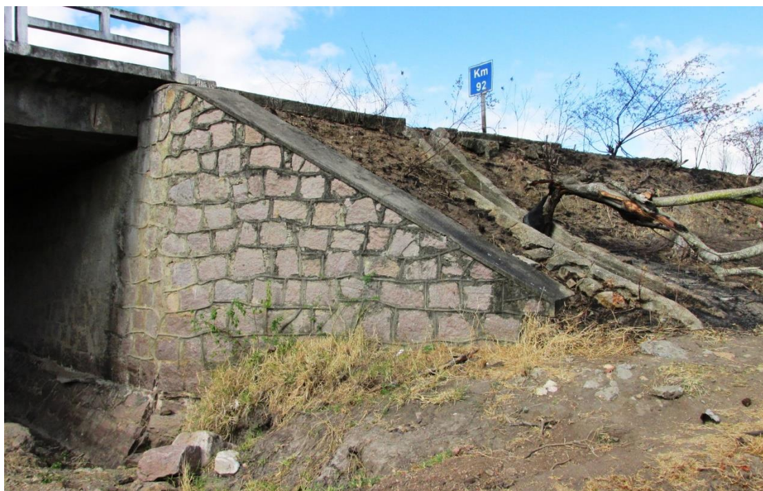
Figura 42 - Vista do muro de ala lateral à obra.
