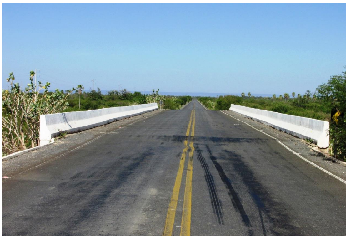
Figura 131 – Vista superior da OAE
