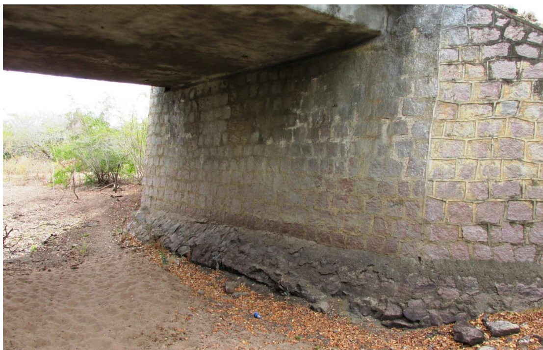
Figura 54 – Vista da mesoestrutura da obra
