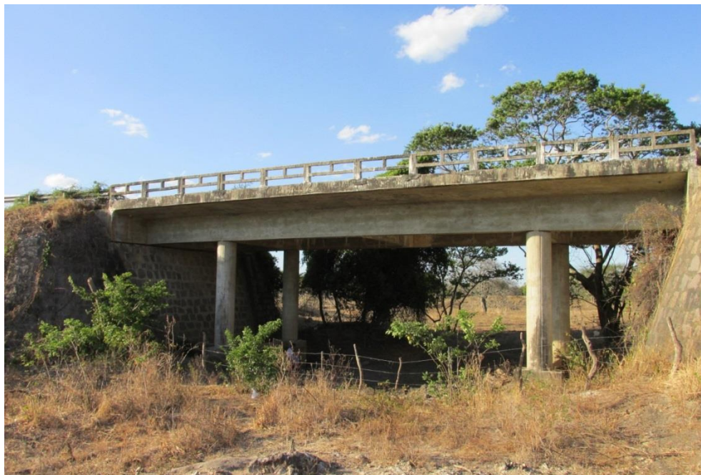
Figura 28 – Vista lateral da OAE
