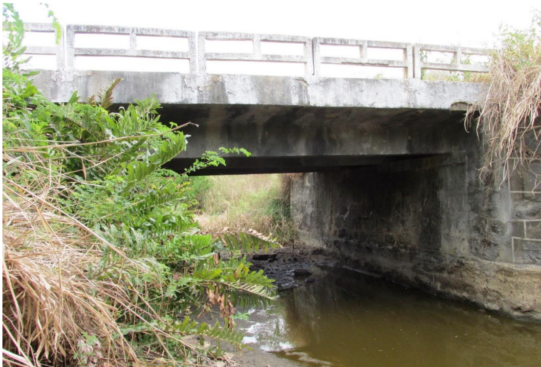
Figura 60 – Vista lateral da OAE
