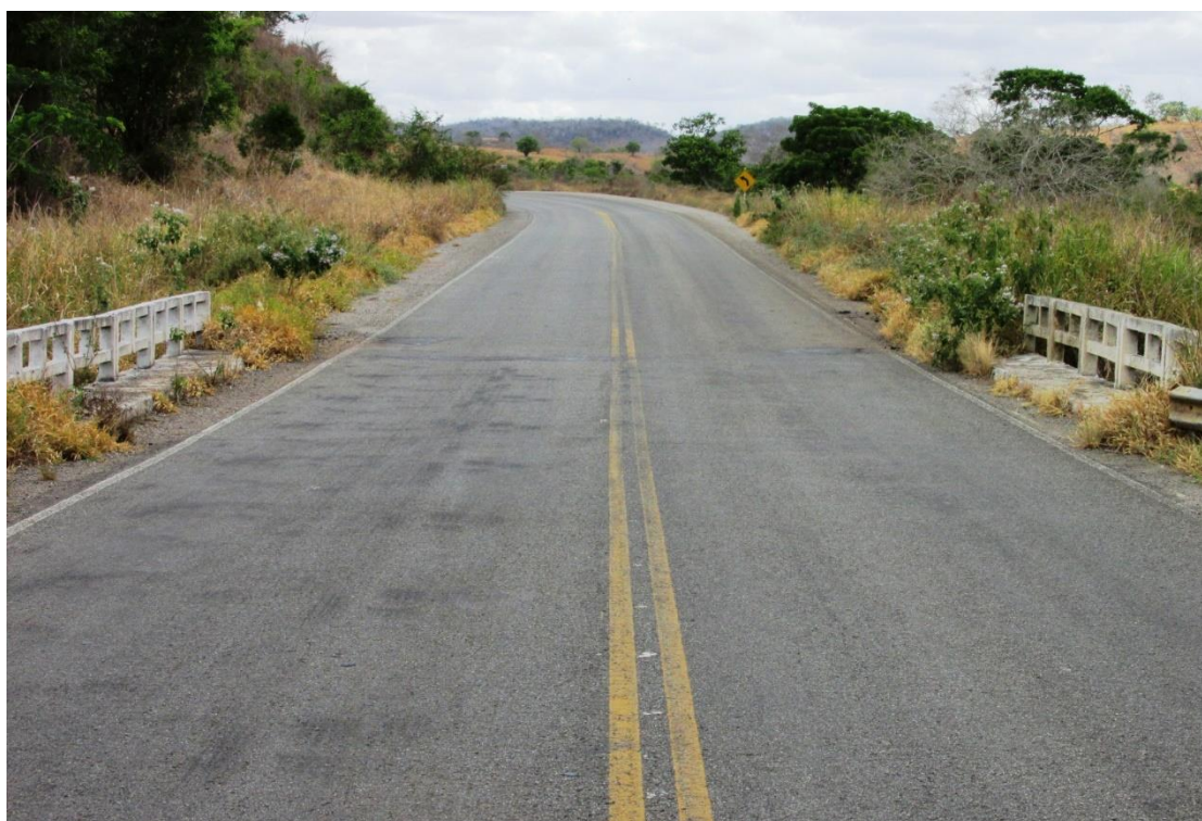
Figura 59 – Vista superior da OAE
