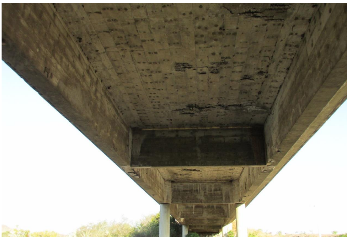
Figura 33 – Vista inferior da OAE
