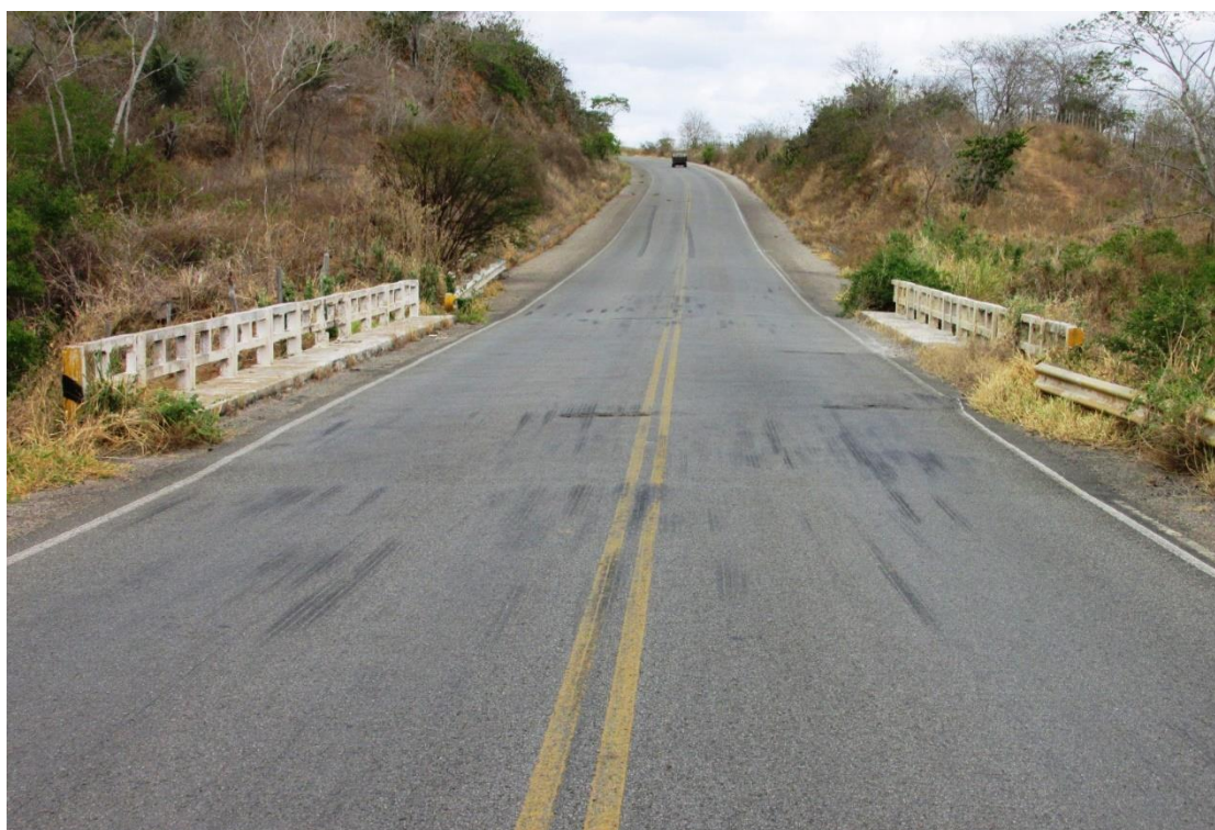
Figura 55 – Vista superior da OAE
