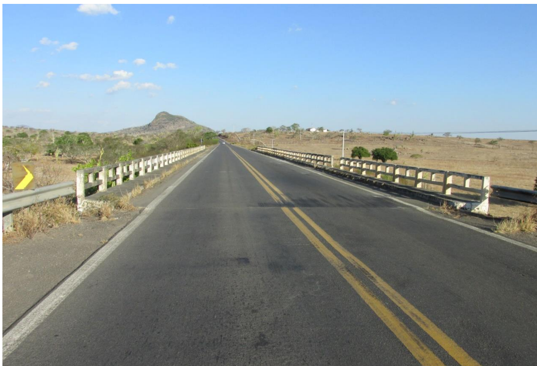
Figura 31 – Vista superior da OAE
