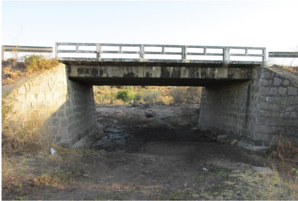
Figura 36 – Vista lateral da OAE
