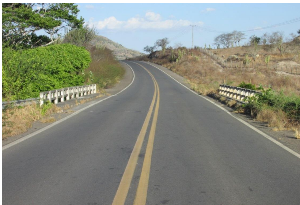
Figura 27 – Vista superior da OAE
