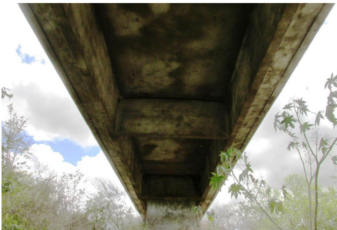
Figura 49 – Vista inferior da OAE
