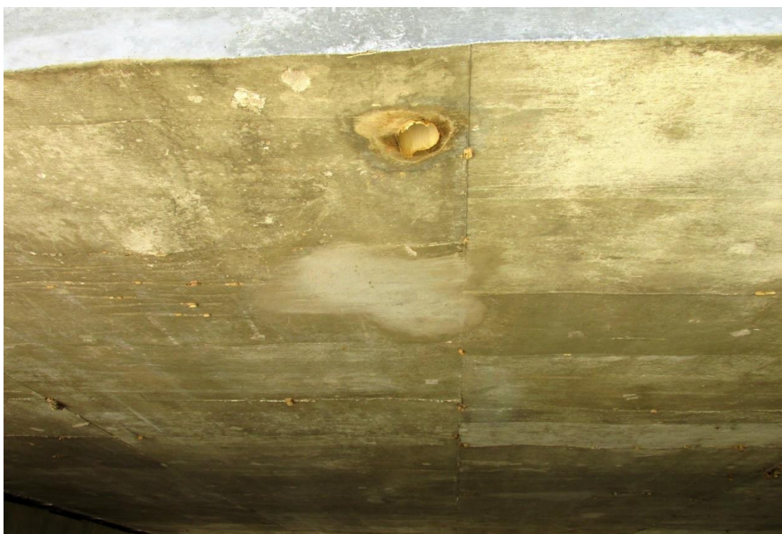
Figura 117 – Vista inferior da OAE
