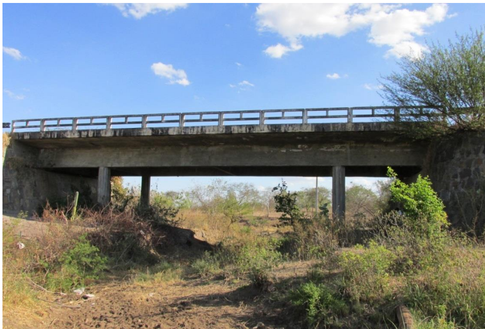
Figura 24 – Vista lateral da OAE
