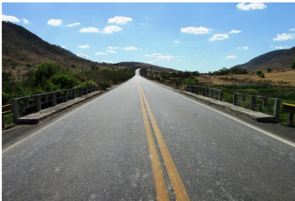
Figura 11 – Vista Superior da OAE
