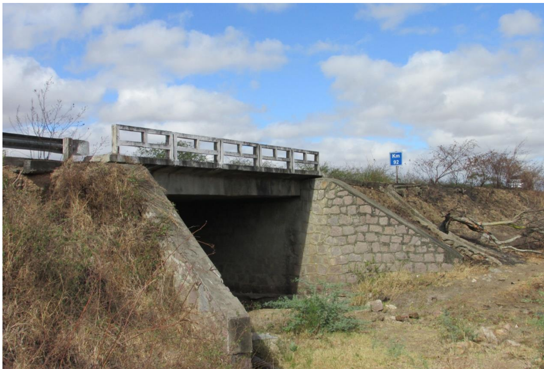
Figura 40 – Vista lateral da OAE
