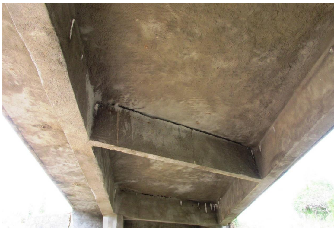
Figura 57 – Vista inferior da OAE
