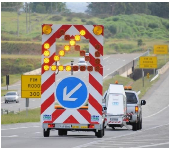
Figura 3 – Levantamento com FWD em andamento
