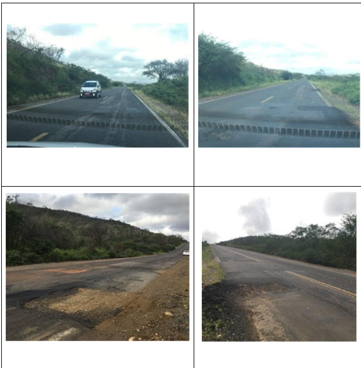
Quadro 3.3.1.2 – Registro fotográfico do trecho entre o km 37+080 e km 40+400 (Trecho 2)
