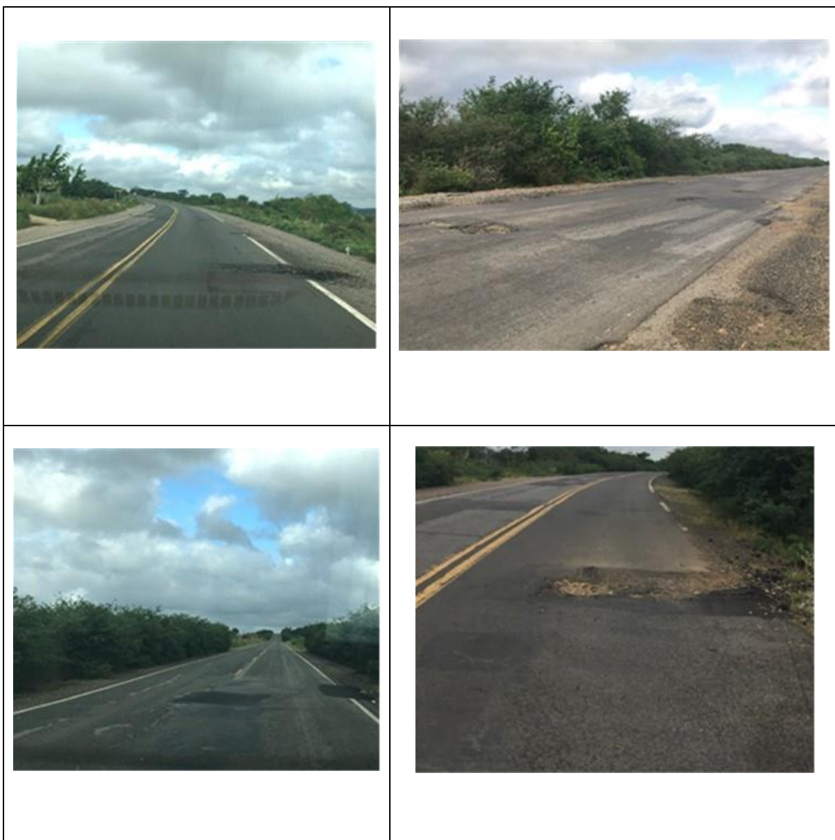
Quadro 3.3.1.3 – Registro fotográfico do trecho entre o km 40+400 e o km 57+000 (Trecho 3)
