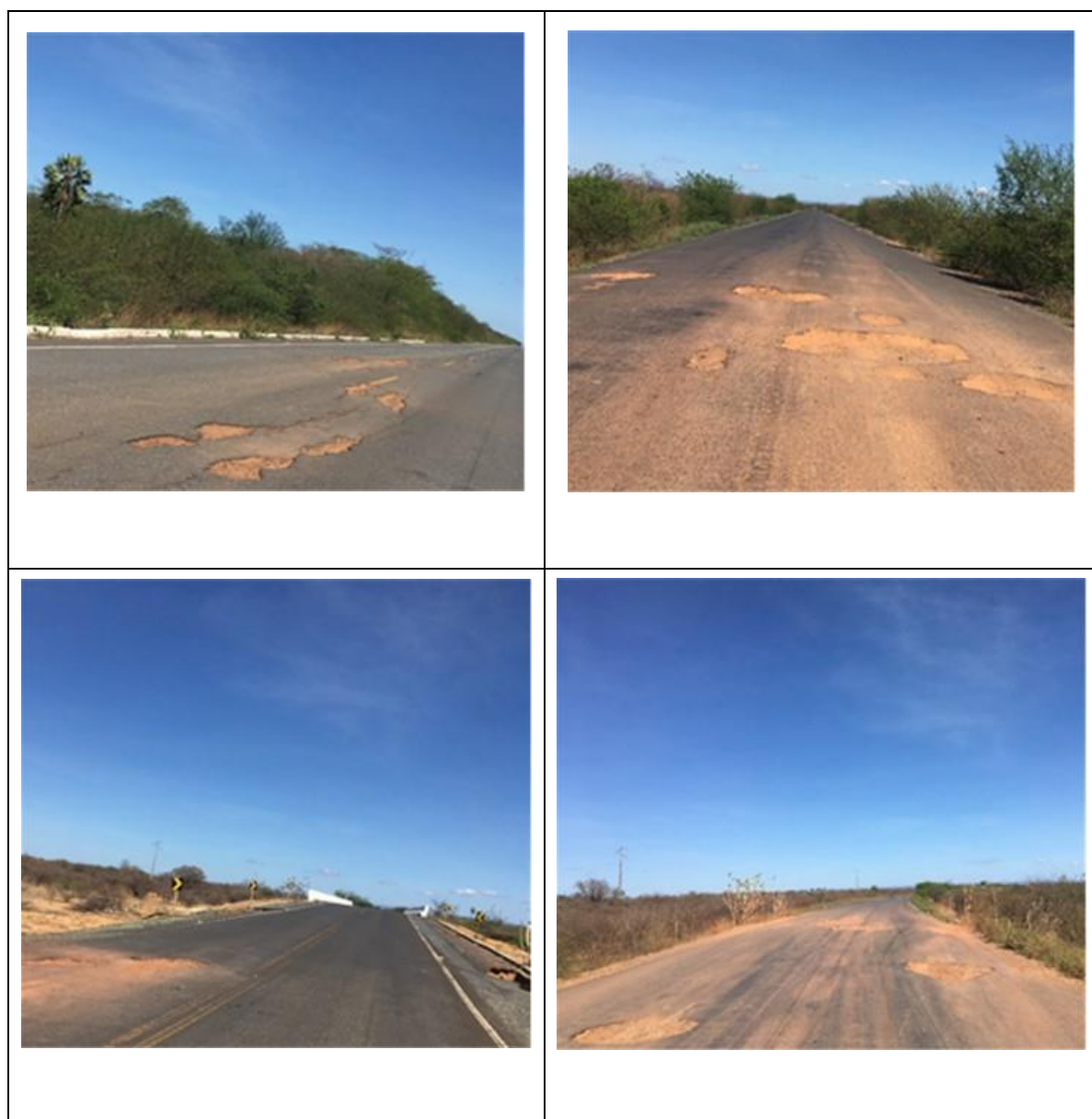
Quadro 3.3.1.8 – Registro fotográfico do trecho entre o km 59+500 e o km 78+000 (Trecho 17)
