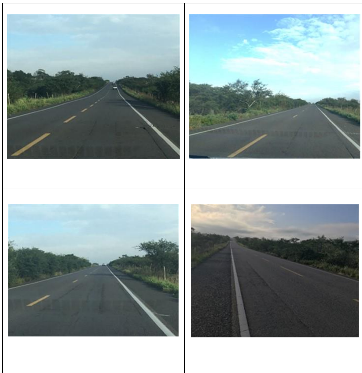
Quadro 3.3.1.1 – Registro fotográfico do trecho entre o km 9+100 e km 10+920
