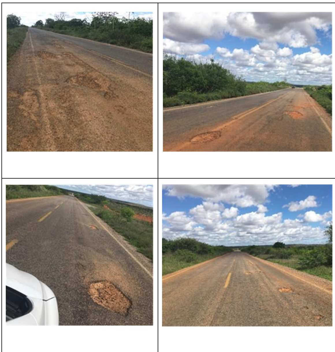
Quadro 3.3.1.9 – Registro fotográfico do trecho entre o km 78+000 e o km 81+800 (Trecho 20)
